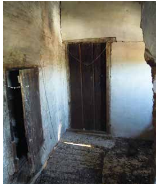
Figura 13. Interior del tramo de letrinas, con la puerta que daría acceso a los cubículos y el entarimado que oculta el hueco de la escalera. Foto: Ana J. Mateos.
