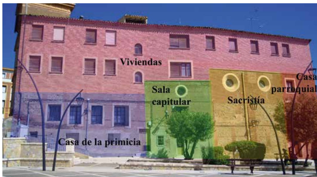
Figura 7. Estado actual de los edificios del Planillo, indicando los distintos bloques que lo componen. Elaboración propia.
