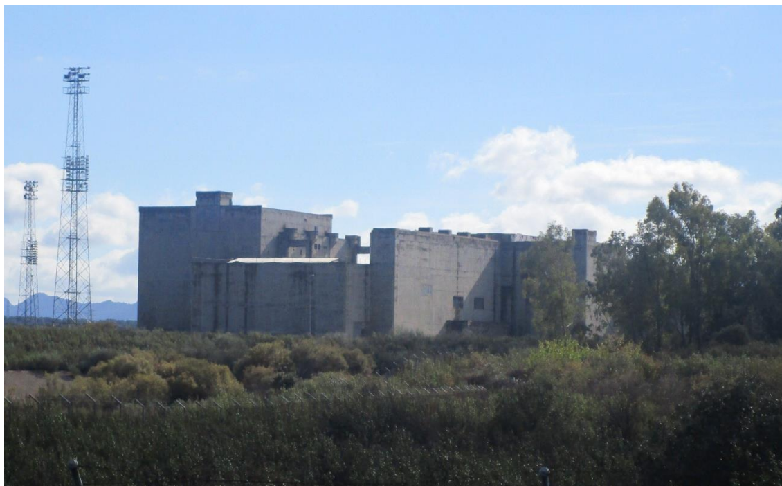
Figura 7 La inmensa mole de hormigón de la Central non nata de Valdecaballeros, abandonada a su suerte
