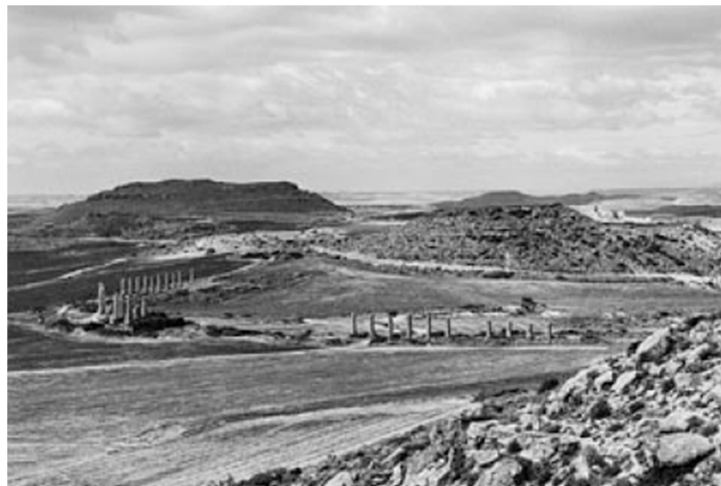
Fotografía de una vista general del acueducto.
