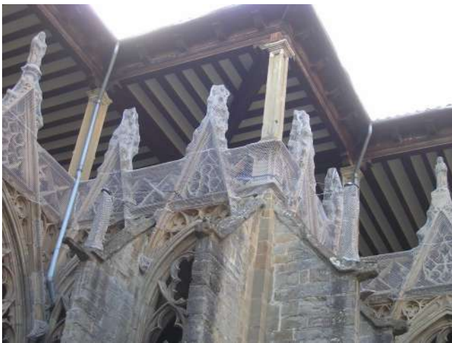
Foto 3. Durante los estudios previos se realizaron actuaciones de urgencia como la colocación de redes de contención en el sobreclaustro y tensores en los pináculos. Fotografía Gobierno de Navarra.
