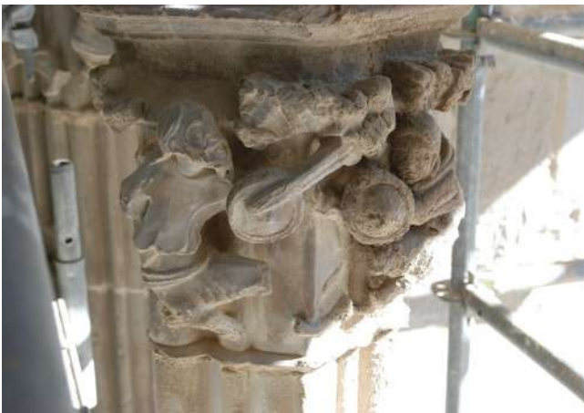
Foto 1. Capitel de combate de híbridos de humano y dragón. Se observa el avance de deterioro y la diferencia de estado de conservación de la zona más expuesta al exterior y la más interna. Fotografía Gobierno de Navarra
