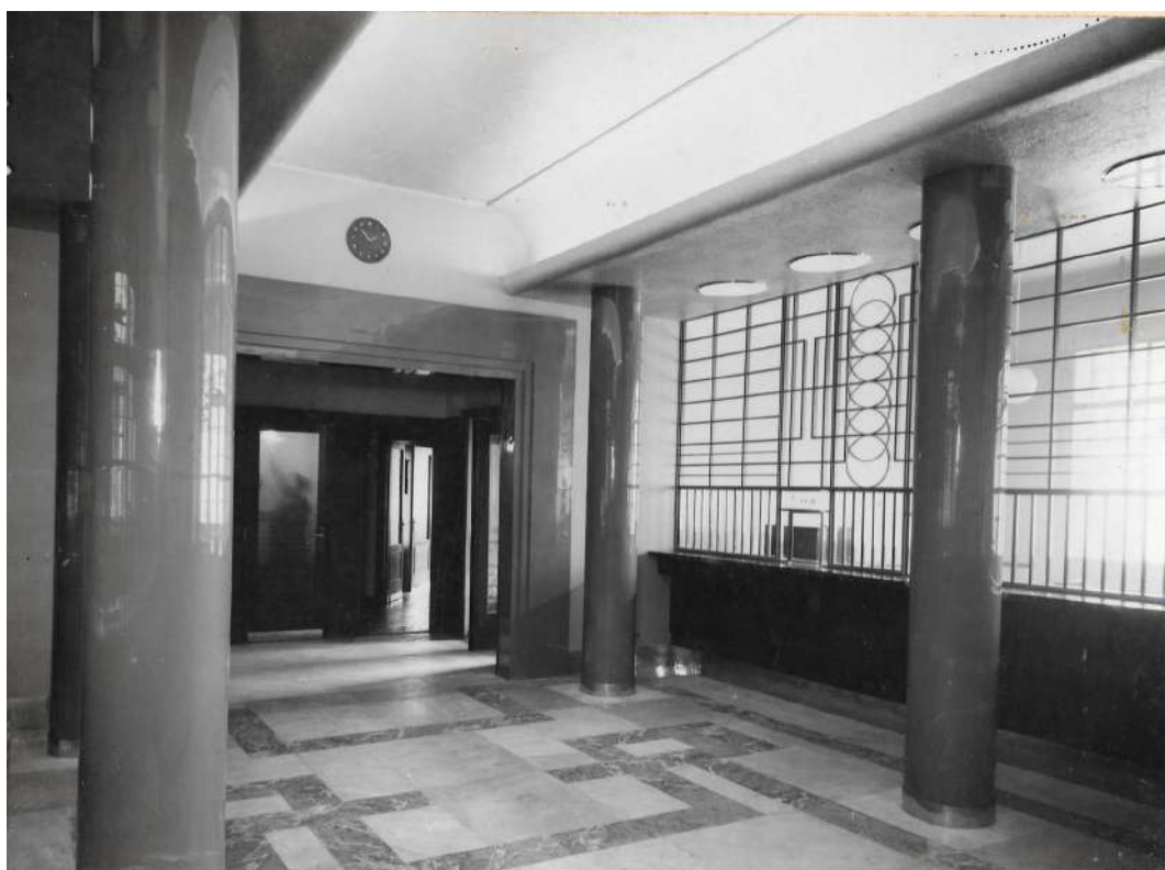
Vista general del patio de operaciones de la CAMP en su inauguración.
