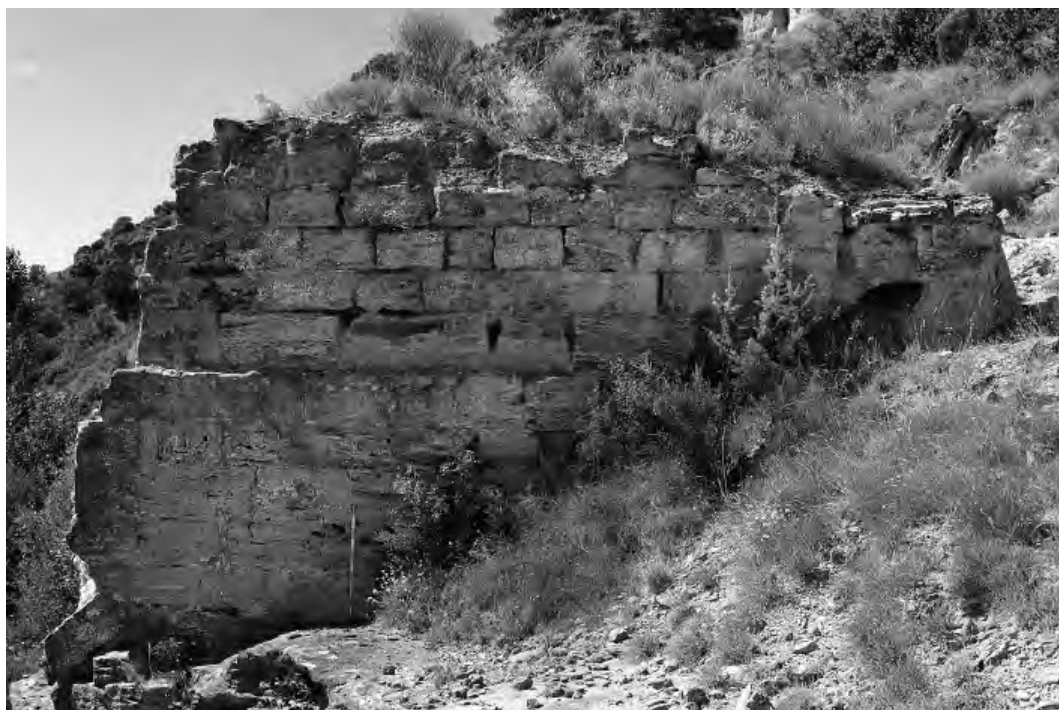
Vista norte del arranque oeste del puente.
