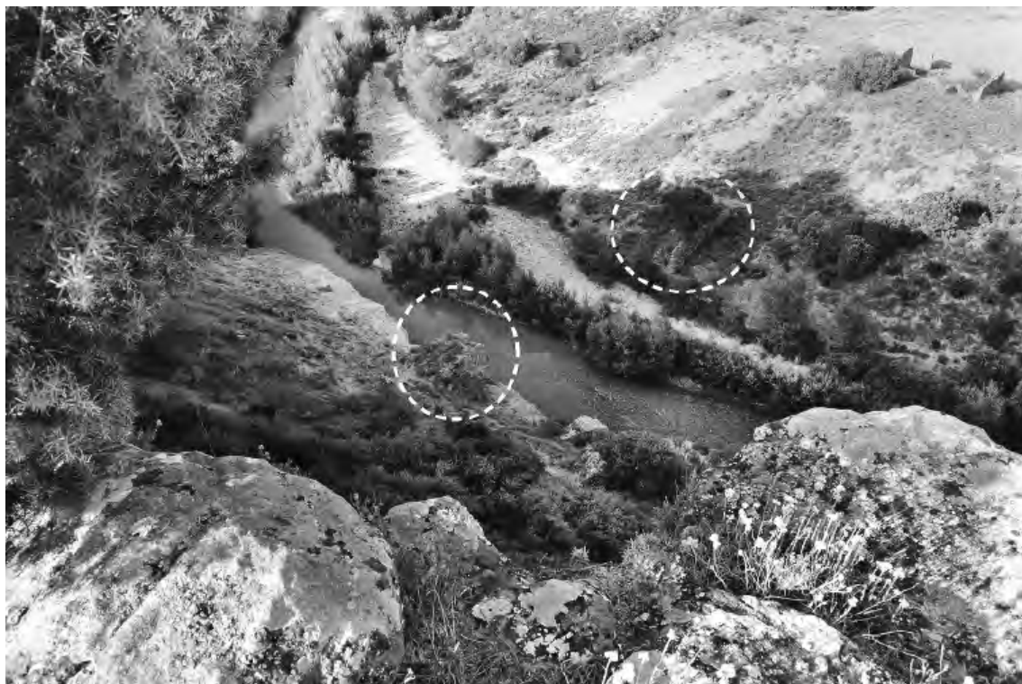
Estribos del puente (vista superior).
