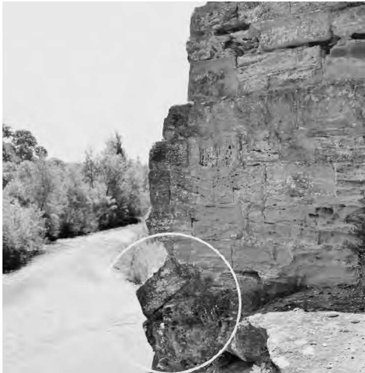
Vista detallada de la dovela del puente, en el estribo oeste.
