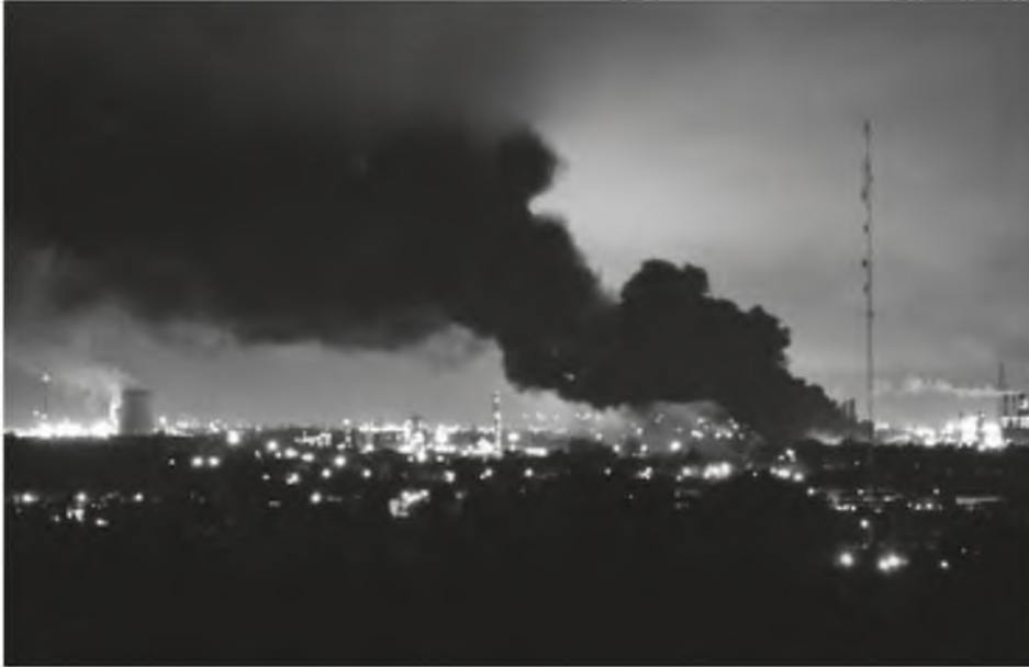
Figura 11. Imagen del incendio en la destilería YPF. Fuente: Télam. http://www.telam.com.ar/notas/201304/12399-ypf-aseguro-que-se-logro-contener-el-incendio-en-su-refineria-de-la-plata.html
