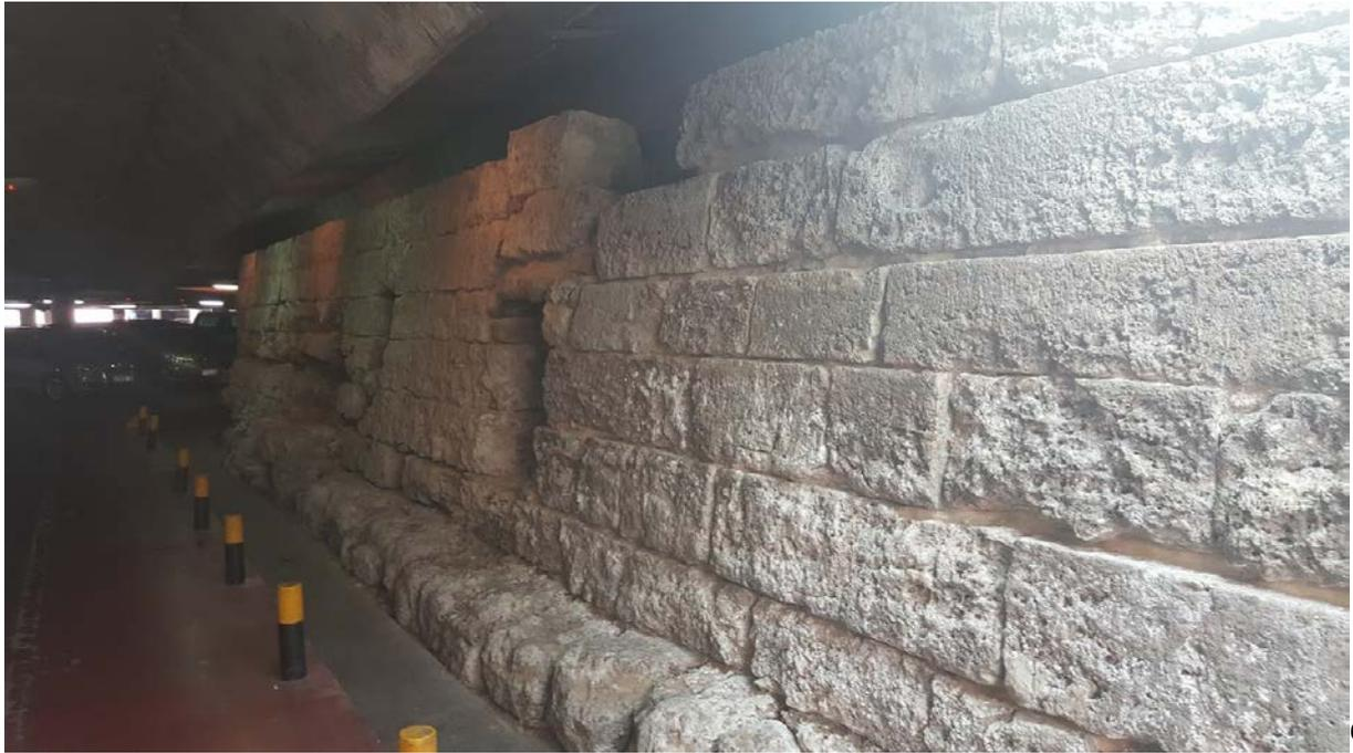
La cara exterior esta inclinadas como muro de defensa y presenta una base ancha.
