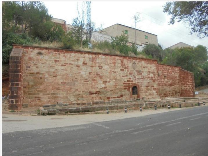
**Fig. 9). Detalle del paño de la muralla en la cara oeste de Almedina, donde se aprecia la entrada a la galería del manantial que surte las pilas de la fuente pública. Los sillares de la muralla procederían de la cantera próxima.**
