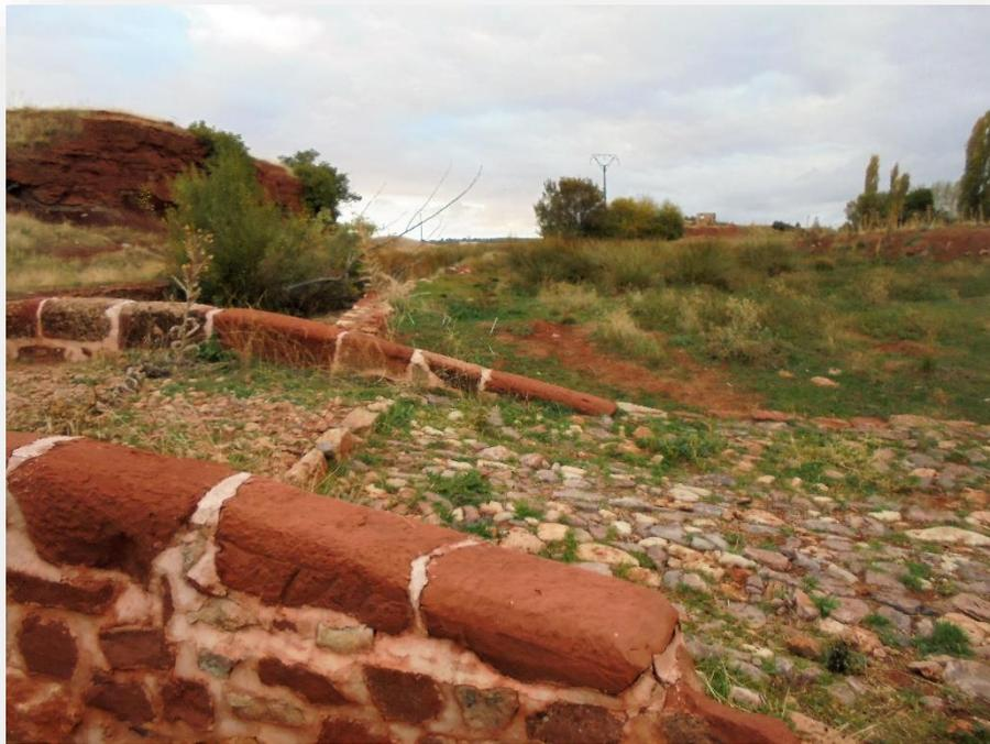
*Fg.23) Detalle del pretil con sillares de arenisca roja y de la rodadura de la calzada*
