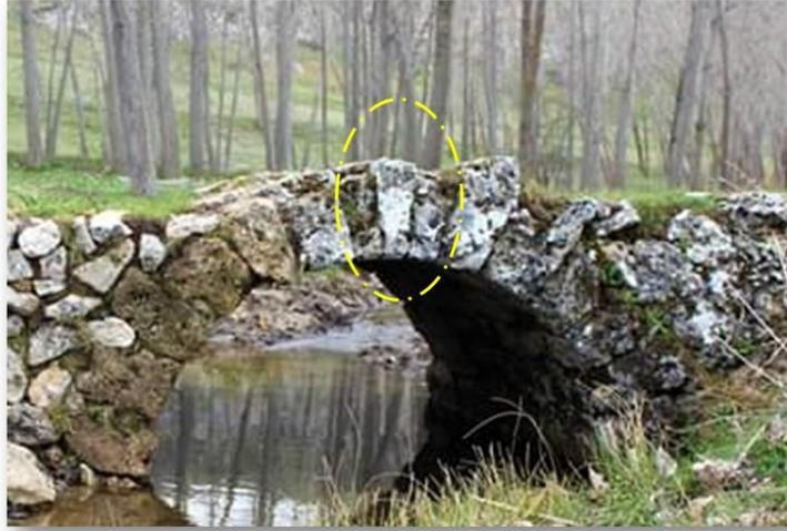
***Fg.19) Detalle de la clave del puente en Cañada Hermosa***
