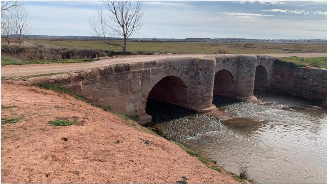
***Fg.38) Vista del puente aguas abajo. Se aprecian los tres arcos, los contrafuertes semicilíndricos, los estribos y las inscripciones***
