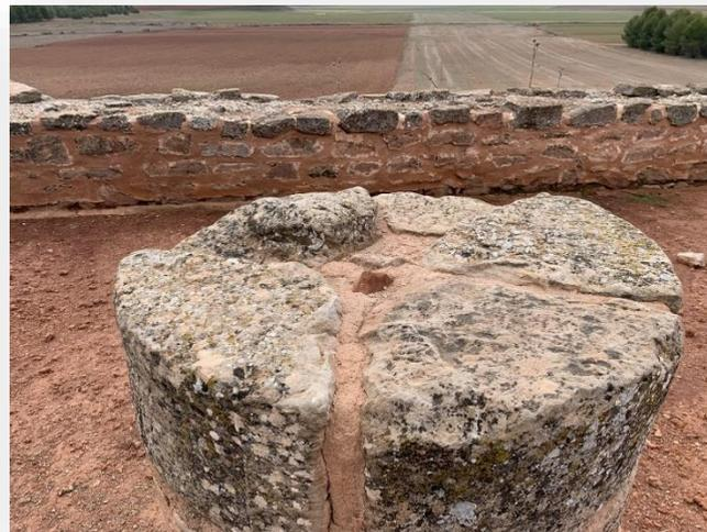
**Fig.22) Detalle de los sillares del basamento trabados con argamasa**
