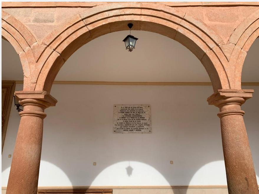
**Fg.43) Detalle del cuerpo inferior del patio porticado con arcos de medio punto sobre columnas toscanas**
