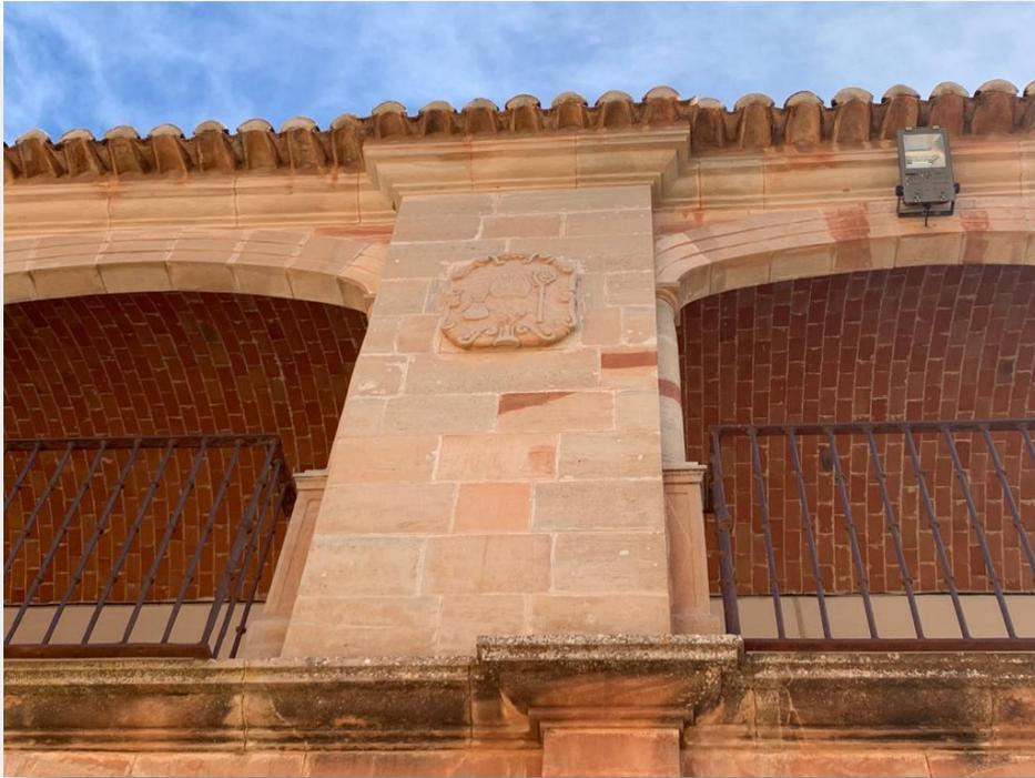
**Fg.44) Detalle de los arcos rebajados sobre columnillas toscas sobre plintos en el cuerpo superior**
