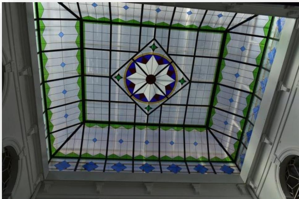
***Fg.21) Magnífico lucernario del patio de luces, formado por vidrieras decoradas incrustadas en una estructura de perfiles metálicos.***
