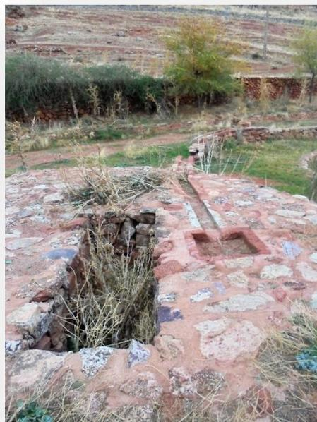
***Fg.26) En la base de la noria, se aprecia el brocal del pozo artesiano y la canaleta donde se vierte el agua extraída. Falta el sistema de extracción de agua mediante una rueda con cangilones, así como el sistema de engranajes y ejes para el accionamiento de la rueda.***
