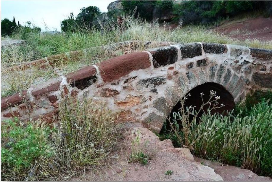
***Fg.21) Detalle del pretil y dovelas del arco aguas abajo***
