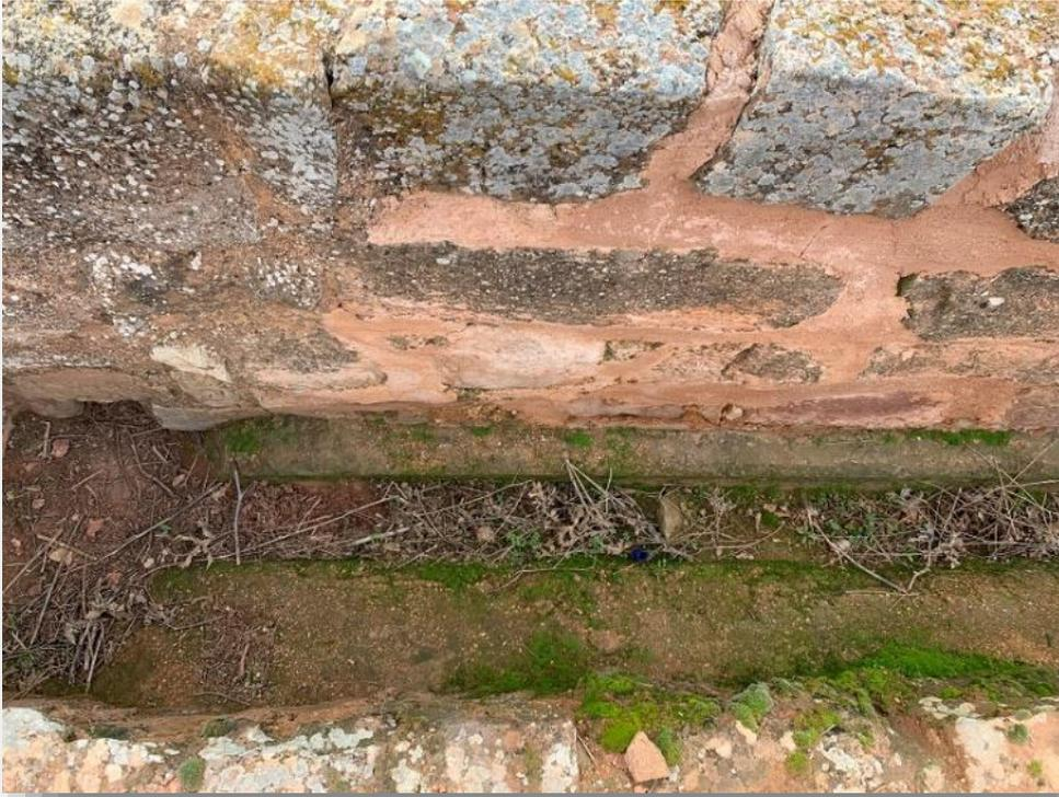
***Fg.26) Detalle del mechinal y de la canaleta labrada en piedra colocada perimetralmente en el muro como desagüe para evacuación de aguas pluviales.***
