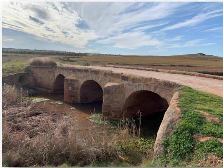
***Fg.37) Vista del puente aguas arriba. Se aprecian los tres arcos, los tajamares y los estribos***
