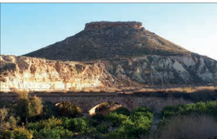
Figura 4. Vista de la cara norte de Cerro de Alcalá, se observa su espesor y su posición sobre una gran masa de margas.
