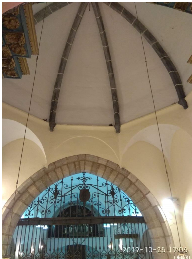
Imagen de la bóveda. Fuente: elaboración propia
