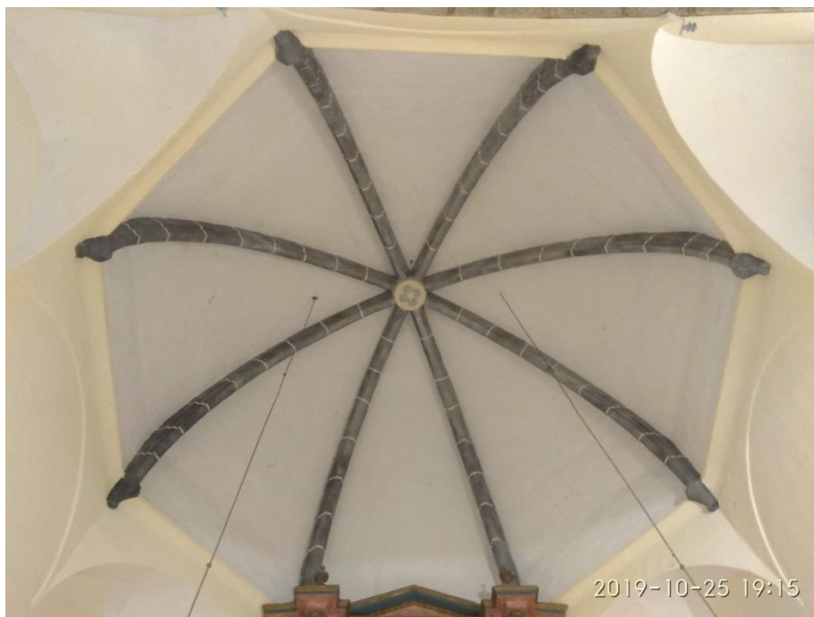
Imagen de la bóveda. Fuente: elaboración propia
