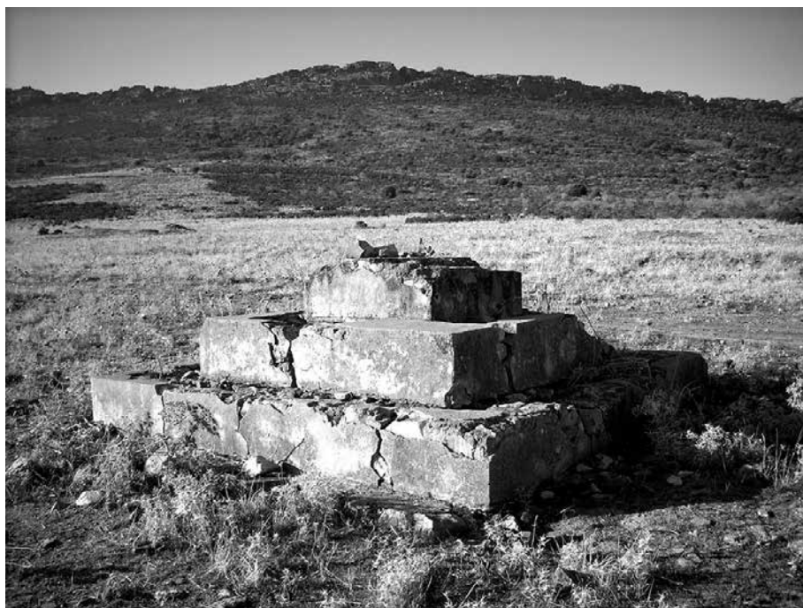
Fotografía 1: Estado actual de la peana de cemento donde estaba la cruz.
