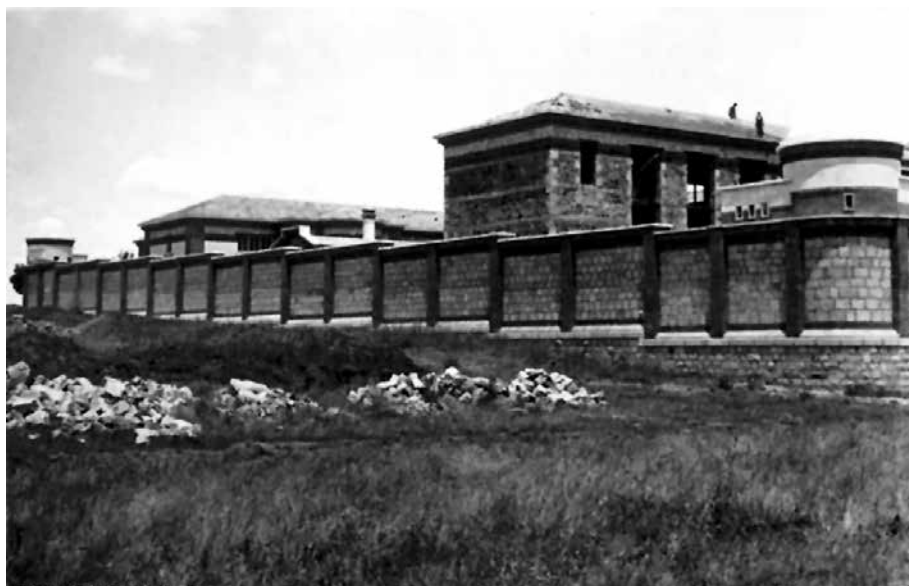
Obras en la nueva prisión provincial de Cáceres, 1 de junio de 1936 (2). Archivo de la Ciudad de Arganda del Rey, Fondo: Arquitectos Aranguren.
