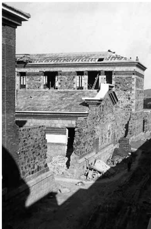
Obras en la nueva prisión provincial de Cáceres, 1 de junio de 1936 (1). Archivo de la Ciudad de Arganda del Rey, Fondo: Arquitectos Aranguren.
