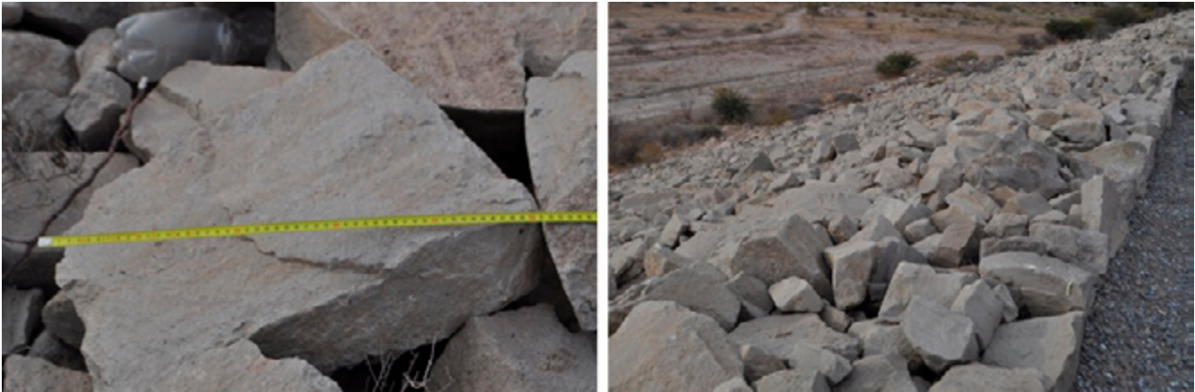
Figura 14. Detalle y aspecto general del rip-rap existente en el cierre lateral, donde se puede apreciar el tamaño del material pétreo colocado
