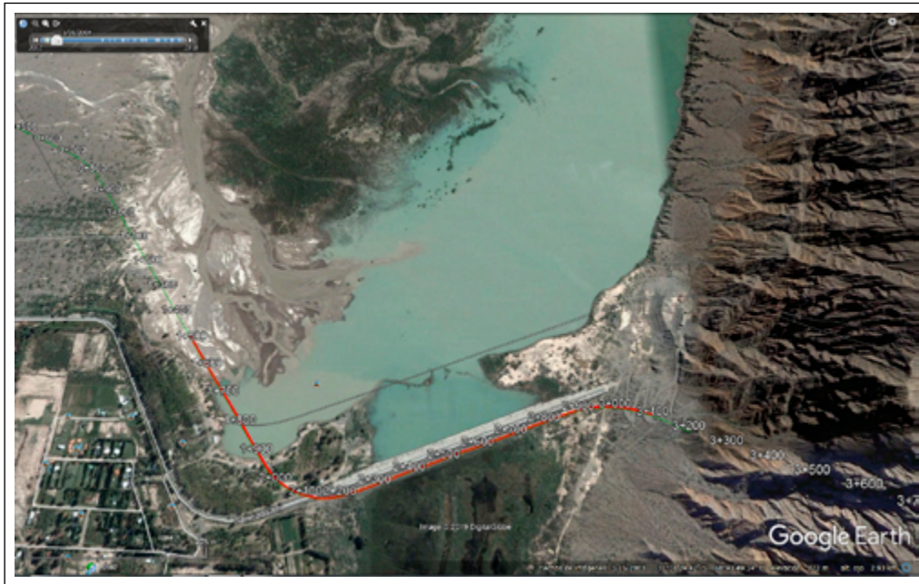
Figura 2. Ubicación del terraplén de acceso oeste al túnel de la sierra de Marquesado. Situación de crecientes extraordinarias. Entre progresivas 960-1920, terraplén nuevo, y entre progresivas 2100-2900, terraplén adosado a cierre lateral existente
