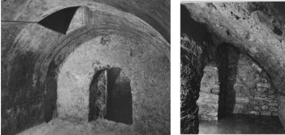
A l'esquerra, la cripta excavada sota la sala amb cúpula, en convertir-se la vila en edifici sepulcral. A la dreta, interior de la subcripta.
