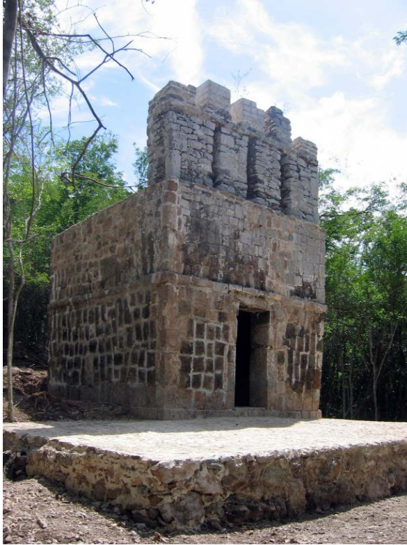
Figura 17. Edificio principal de Chunyaxnic tras su consolidación (Fotografía de Antonio Benavides C.).
