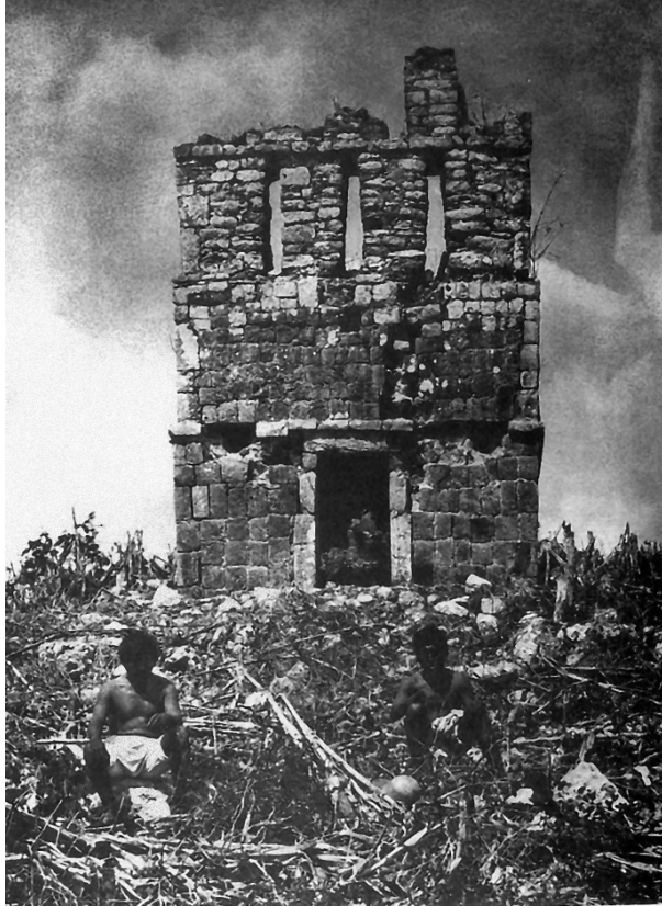
Figura 16. Edificio principal de Chunyaxnic, Campeche (Según Maler, 1997).
