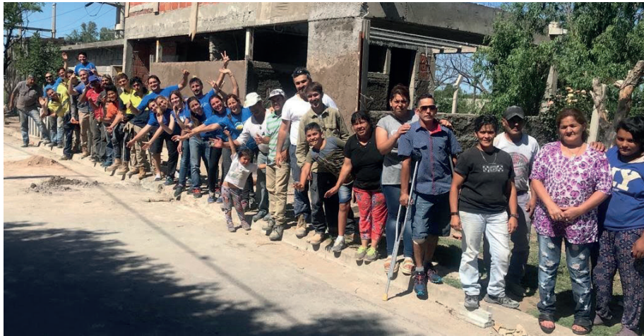
[fig. 4] Vecinos y voluntarios realizando trabajos de construcción.
