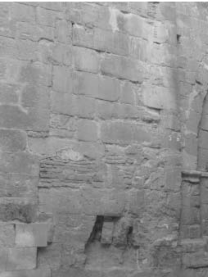
Foto 28. Mezquita mayor. Restos del muro de la qibla
