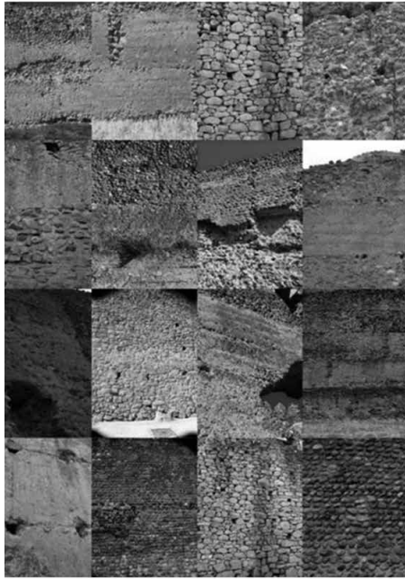
Tapial o Mampostería encofrada
