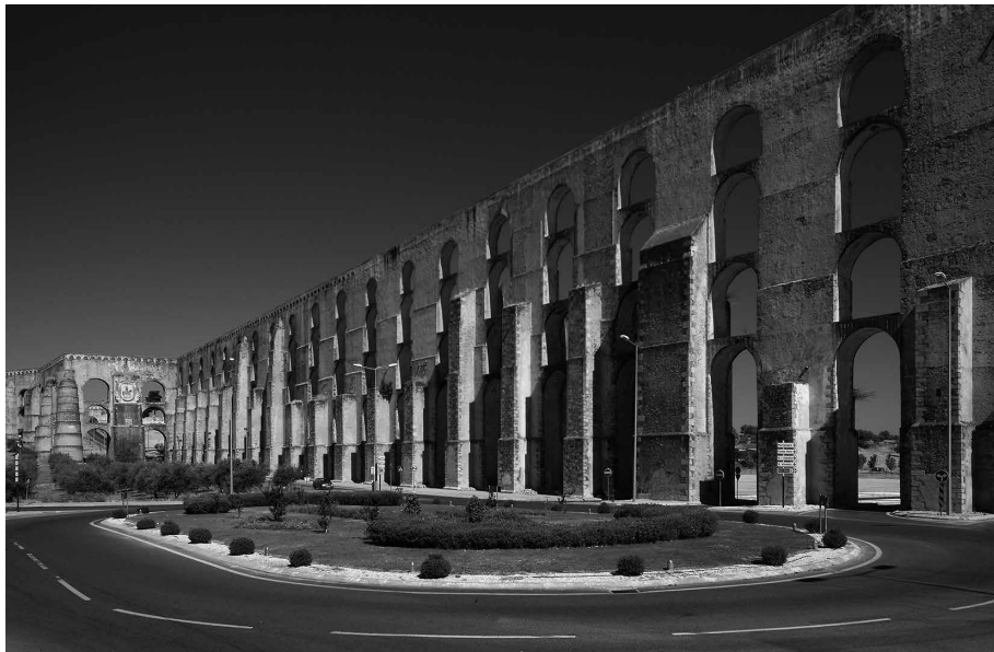
12. Aqueduto da Amoreira.
