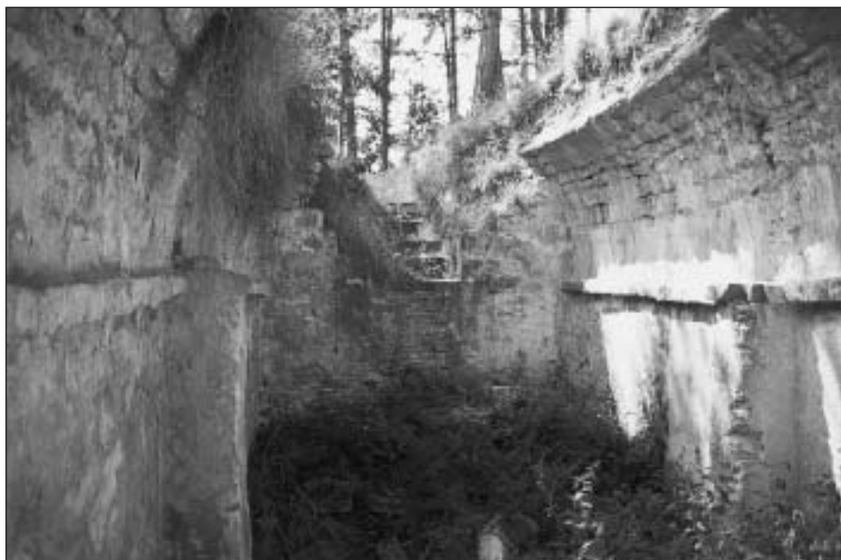
Foto 3. Interior del aljibe
