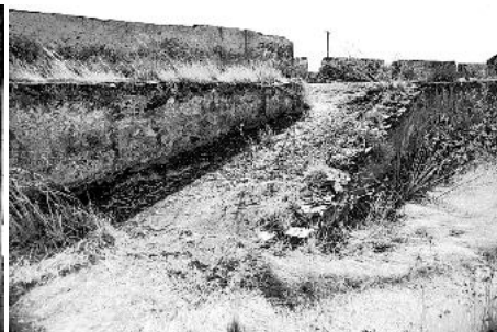
Rampa de subida a la batería artillera sur, antes de las obras.
