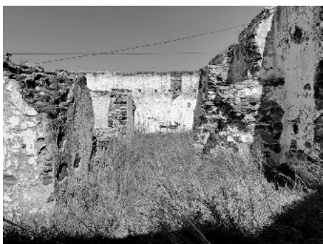
Cocina del cuartel de la tropa, antes de las obras.
