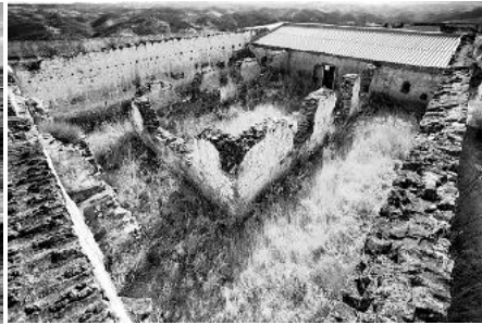
Patio del cuartel de la tropa antes de las obras.
