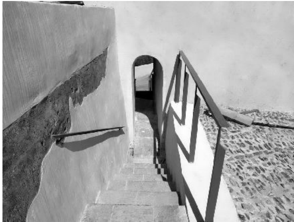
La poterna durante las obras.
