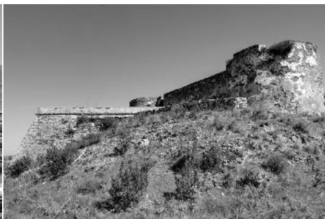
Torre suroeste y batería de poniente, antes de las obras.
