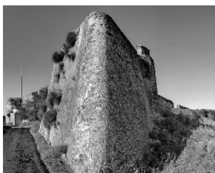
Baluarte encastrado en la torre circular nordeste, antes de las obras.
