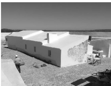
Habitaciones del gobernador, polvorin, capilla y sacristía vistos desde el sureste, durante las obras.
