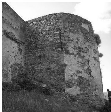
Lectura paramental de la torre noroeste. Paso de torre cuadrangular (s.XIV) a torre circular (s.XVI).
