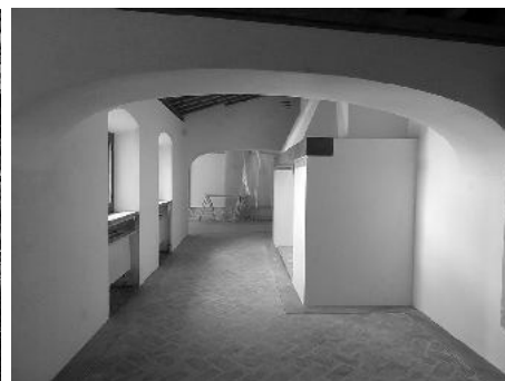
Cocina del cuartel de la tropa, durante las obras. Estos espacios fueron utilizados para el desarrollo expositivo del Centro de Interpretación.
