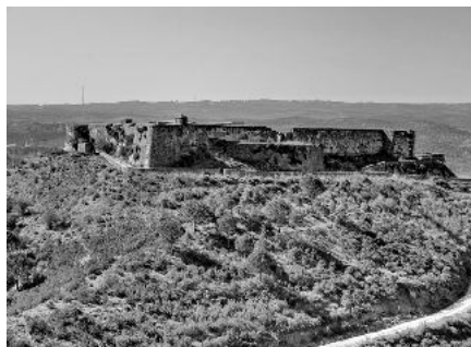
San Marcos visto desde el nordeste, antes de obras.
