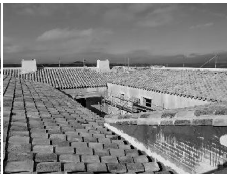
Patio del cuartel de la tropa visto desde el sureste, durante las obras.
