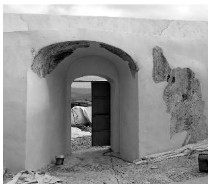
Tramos de revocos originales consolidados e integrados.
