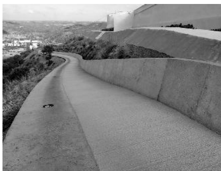
El carril durante las obras.
