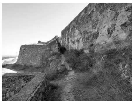
Acceso al "tambor" que protege la entrada norte al fuerte, antes de las obras.
