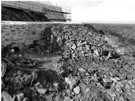
Recuperación del glacis. Relleno del talud exterior al camino cubierto del foso.
