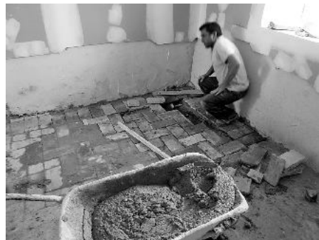
Recuperación de lagunas de pavimento en las habitaciones del gobernador.
