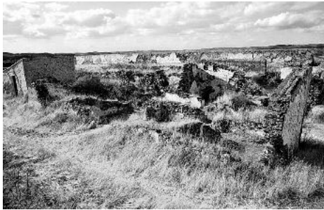
Aspecto de las habitaciones del gobernador, polvorín, capilla y sacristía antes de las obras.
