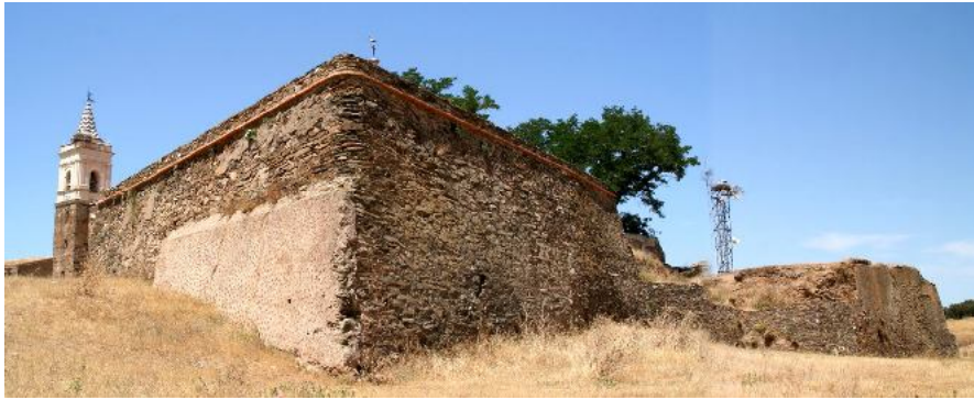
9.1 Imagen general del baluarte de levante antes de la restauración.
