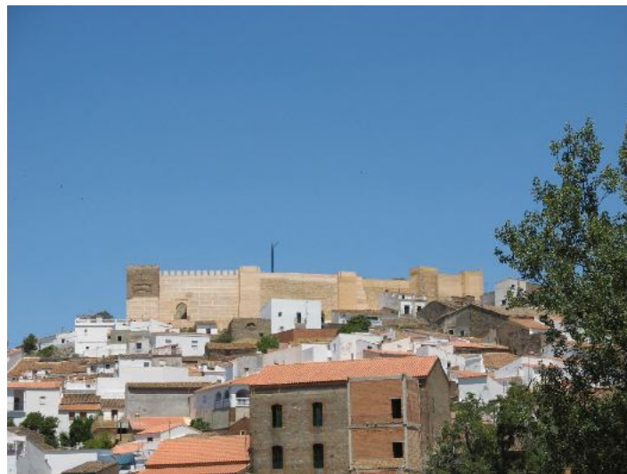
7.2 Imagen general del castillo de Aroche e tras la restauración. Lienzos restaurados en torno a la Puerta de la Reina.
