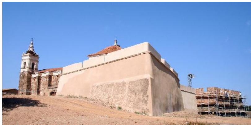
9.2 Imagen general del baluarte de levante durante la restauración.
