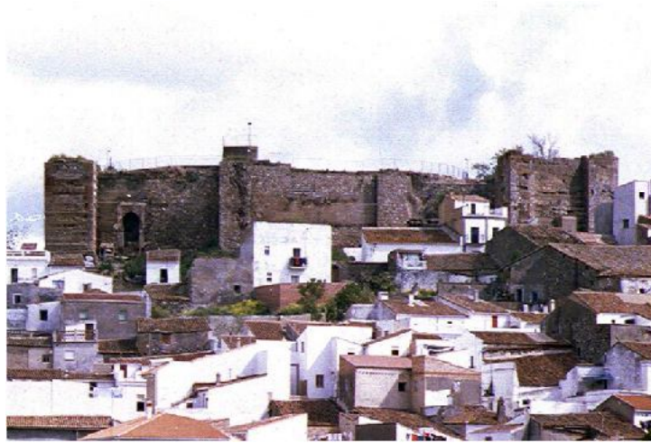
7.1 Imagen general del castillo de Aroche antes de la restauración.
