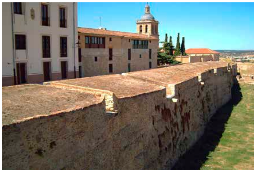
FIGURA 12.- Ciudad Rodrigo: Cortina de la Muralla Real y foso entre las Puertas del Conde y de Amayuelas.
