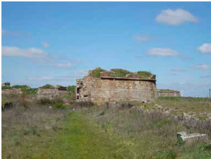
FIGURA 26.- Real Fuerte de la Concepción: Caballerizas, sobre el camino cubierto que une el Fuerte con el Reducto de San José.
