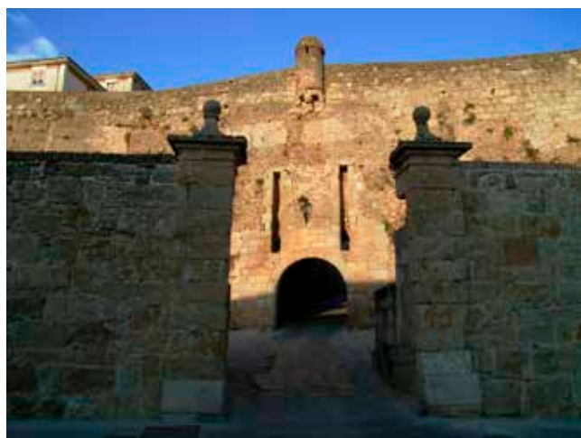
FIGURA 11.- Ciudad Rodrigo: Puerta Magistral de la Colada vista desde la entrada a la barbicana.
