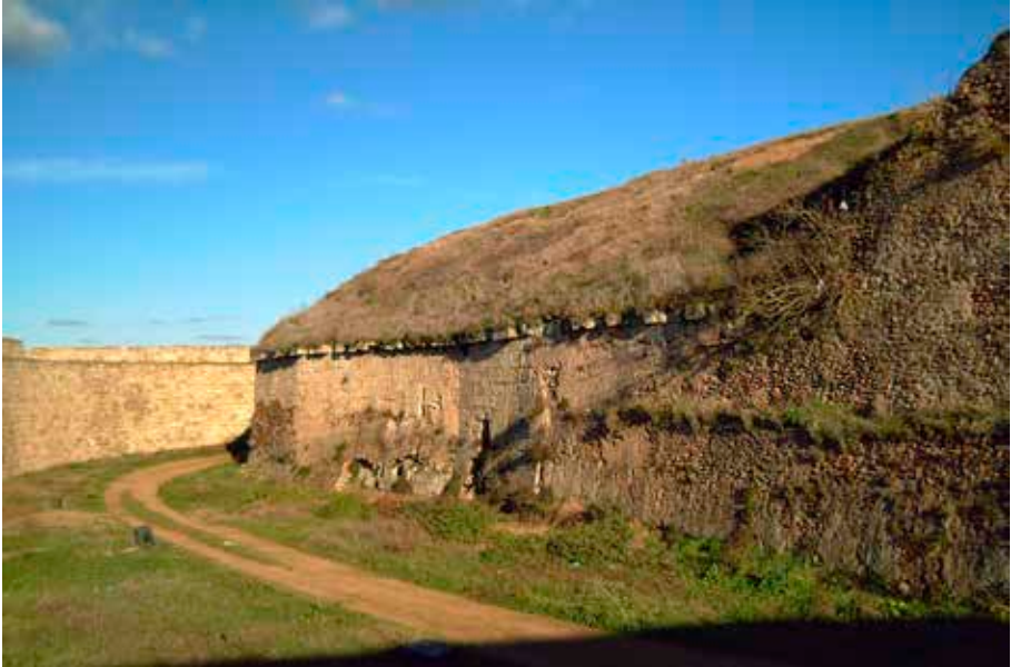
FIGURA 29.- Ciudad Rodrigo: sector de la Muralla Real donde se abrió la “Gran Brecha” durante el sitio inglés de 1812.
