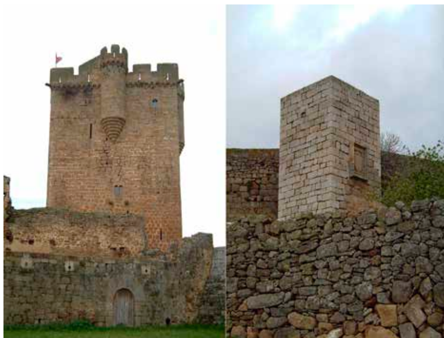
FIGURA 2.- San Felices de los Gallegos: Detalle de la Torre del Homenaje del Castillo y de la cortina de la Cerca Vieja, con torre albarrana pentagonal.
