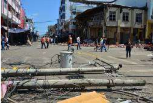
Anexo 3: Zona comercial de Portoviejo después del terremoto del 16A
