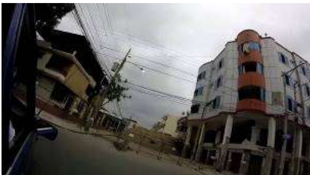
Anexo 10: Infraestructura hotelera afectada por el terremoto del 16A
