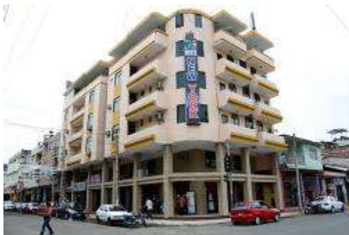
Anexo 6: Hotel New York fue demolido con daños graves en su infraestructura.
