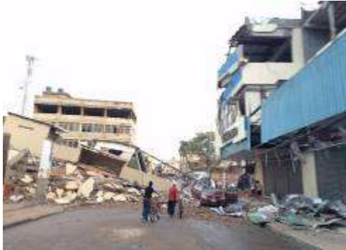
Anexo 4: Zona comercial de Portoviejo después del terremoto del 16A
