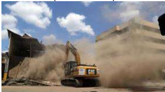
Anexo 9: Demolición Edificios en el Centro de Portoviejo – Zona 0
