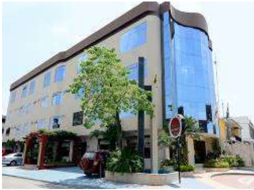
Anexo 7: Hotel Ceibo Dorado fue afectado en su infraestructura en el terremoto del 16ª y actualmente está en reconstrucción
