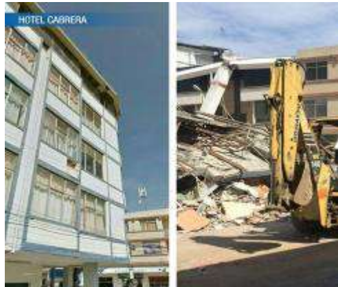
Anexo 5: Infraestructura Hotelera de Portoviejo (antes & después) Hotel Cabrera Fuente: El Diario Manabita
