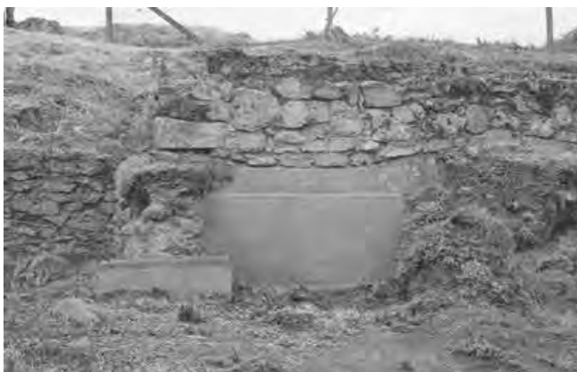
Estado final da restauración en E048, con falso perfil sobre estrutura soporte por bataches
