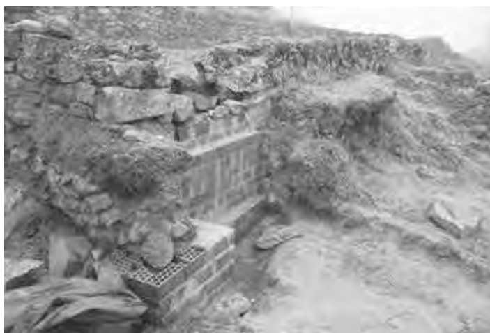
Construción de muro soporte en E048
