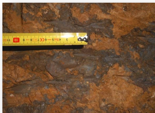
Fig. 6.- Restos de improntas de herramientas en la talla del techo.
