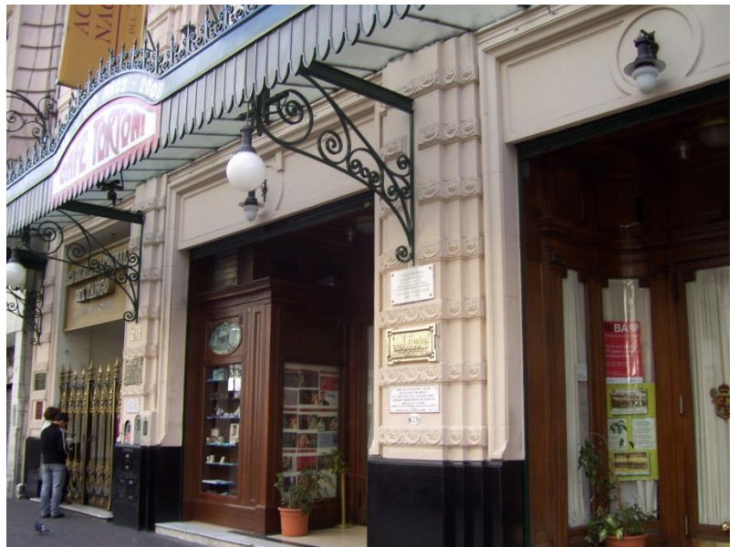
Frente del edificio del Café Tortoni (1893) Av de Mayo 829 - B° San Nicolás (Foto propia)
