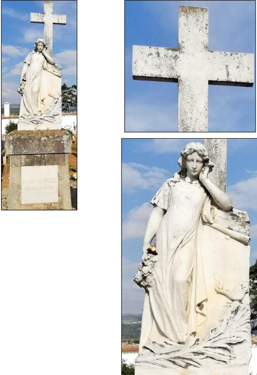
**Figura 3.** Uso de mármol blanco como elemento ornamental en mausoleo con pedestal revestido en roca arenisca. Der. Sup: Evidencias de arenización y huellas de disolución del material. Der. Inf: Disolución y Alteración cromática (amarillamiento). Tumba de Ana Rosa S. de González. Cementerio Central – Tunja. Fuente: Autores.
