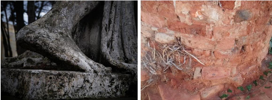
**Figura 5.** Izquierda: Desarrollo de colonización biológica y disolución de elementos de la base de escultura en cemento. Derecha: Desarrollo de colonización biológica (raíces) en la base de la estructura de ladrillo de mausoleo del Siglo XIX. Cementerio Central de Tunja. Fuente: Autores.
