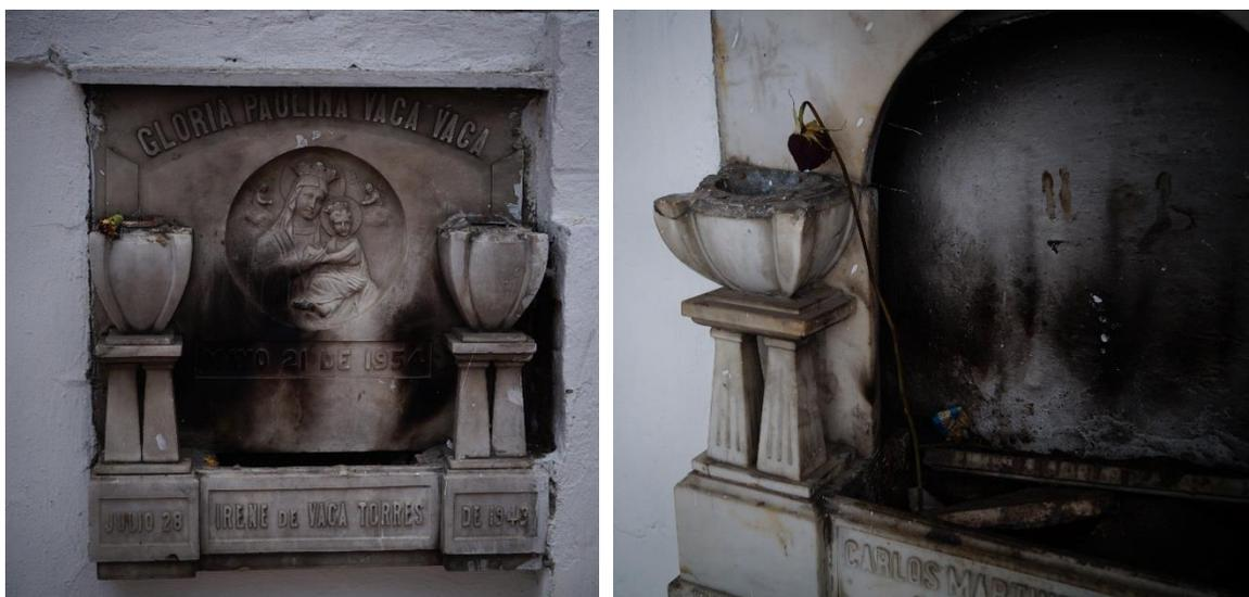
**Figura 4.** Manchas, hollín y desprendimientos de material, debido a las quemaduras ocasionadas por las veladoras utilizadas en rituales fúnebres. Cementerio Central – Tunja. Fuente: Autores.
