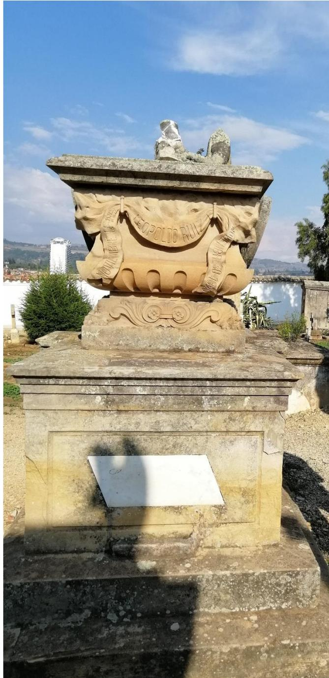
**Figura 1.** Uso de areniscas de cuarzo con matriz arcillosa como elemento de ornamentación y plaqueta de mármol; evidencias de proceso de colonización de varias especies vegetales como hongos y líquenes. Mausoleo de Leopoldo Ruiz. Cementerio Central de Tunja. Fuente: Autores.
