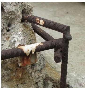
Figura 6: Vista detalle enfierradura Basamento de columna Autor: Romyna Care
