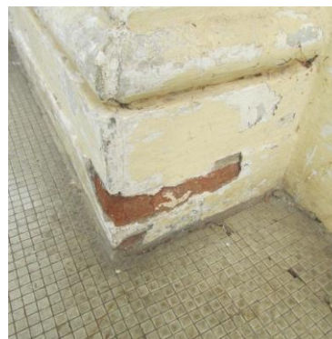
Figura 8: Vista detalle basamento albañilería de ladrillo, pilar adosado Autor: Romyna Care
