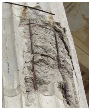
Figura 7: Vista detalle enfierraduras columna Autor: Romyna Care
