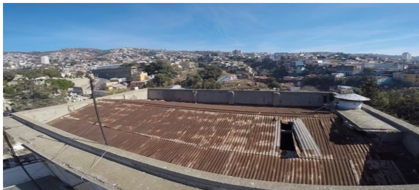
Figura 14: Vista Este de la techumbre de Pórtico
