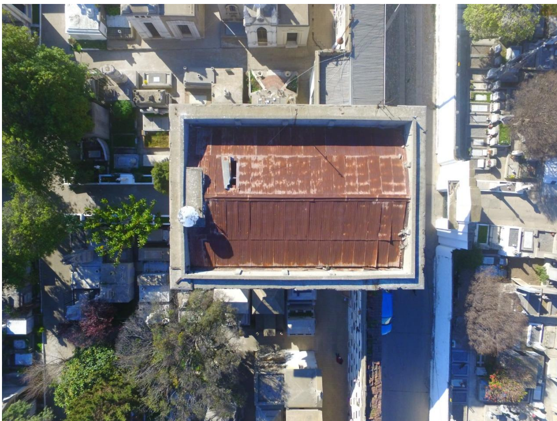
Figura 4: Vista aérea del Pórtico Cementerio N°1 de Valparaíso
