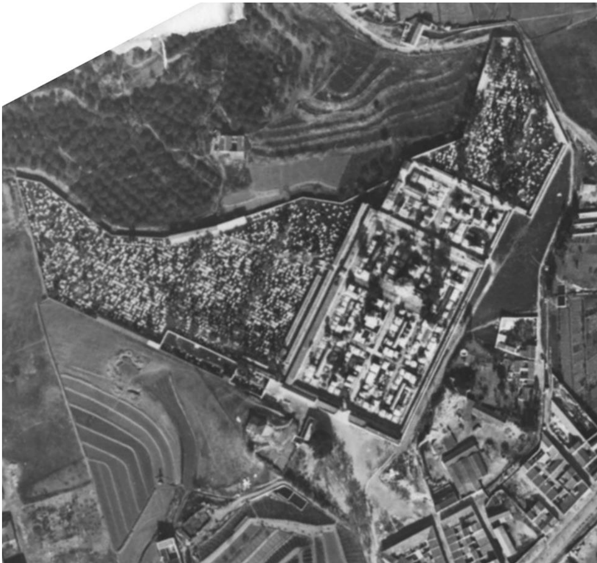
Figura 2. Vista aérea del Cementerio de San Miguel. Antes de 1930. Fotografía: CETFA (girada) (AMM, AG, Sig. 1-C-15-2197).
