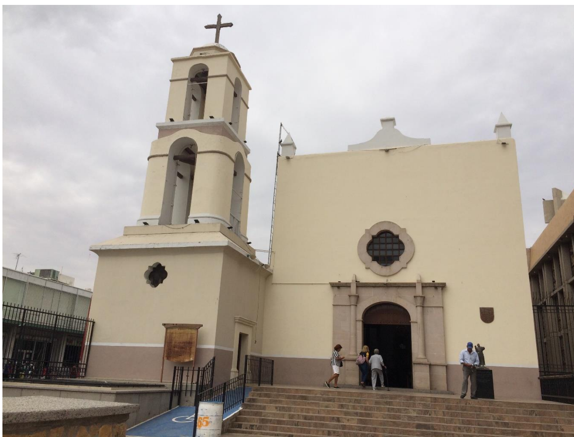
Figura 15. Fachada principal de la misión de Nuestra Señora de Guadalupe, restaurada de 1968-1971. 87
