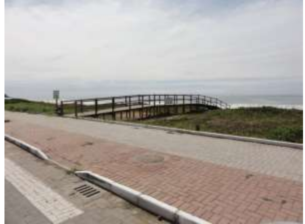
Passarelas de acesso à areia
