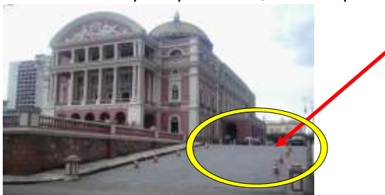
Imagem 01- Fachada principal Teatro, com rampa de acesso.
