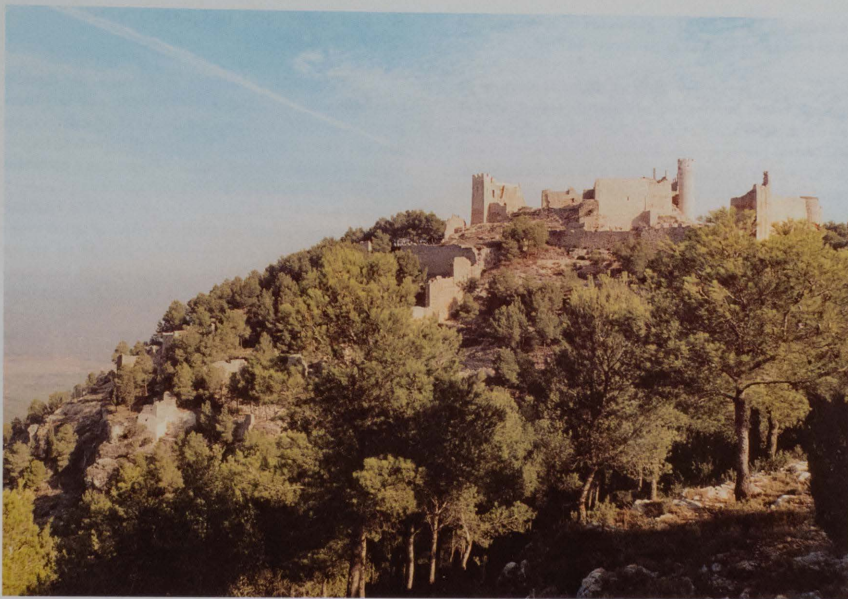
Conjunto fortificado desde sur. La cima de la montaña ocupa el recinto superior, a un nivel más bajo se sitúa el albacar y en la ladera se extiende el poblado.
