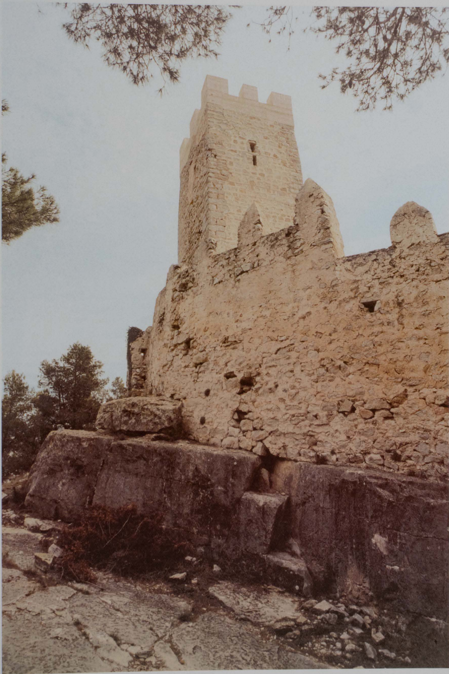
Torre de Poniente, restaurada, vista desde el poblado.
