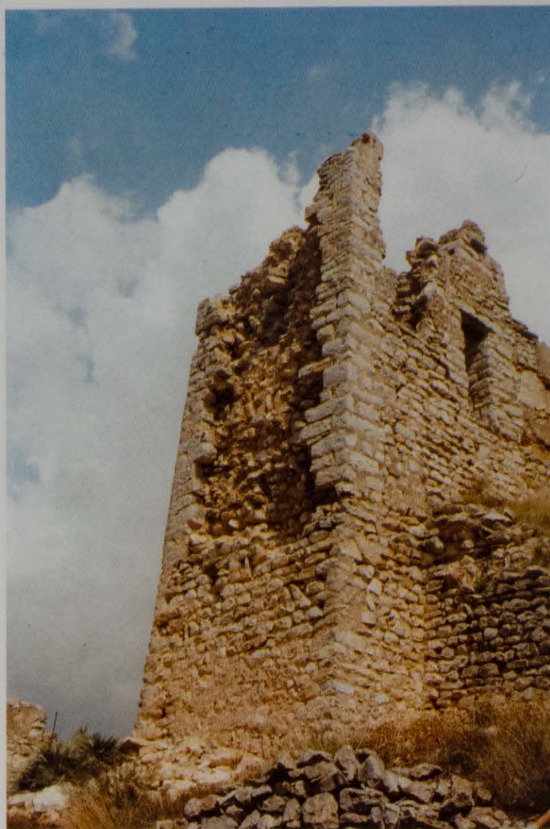
Consolidación de la torre de Poniente. Estado de conservación en el año 1997.
