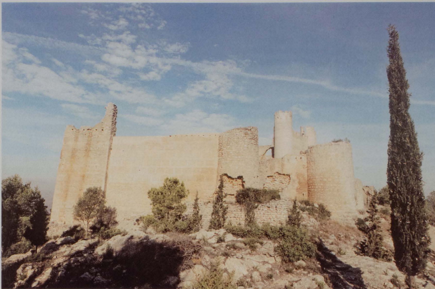
Muro de alafia después de la restauración.
