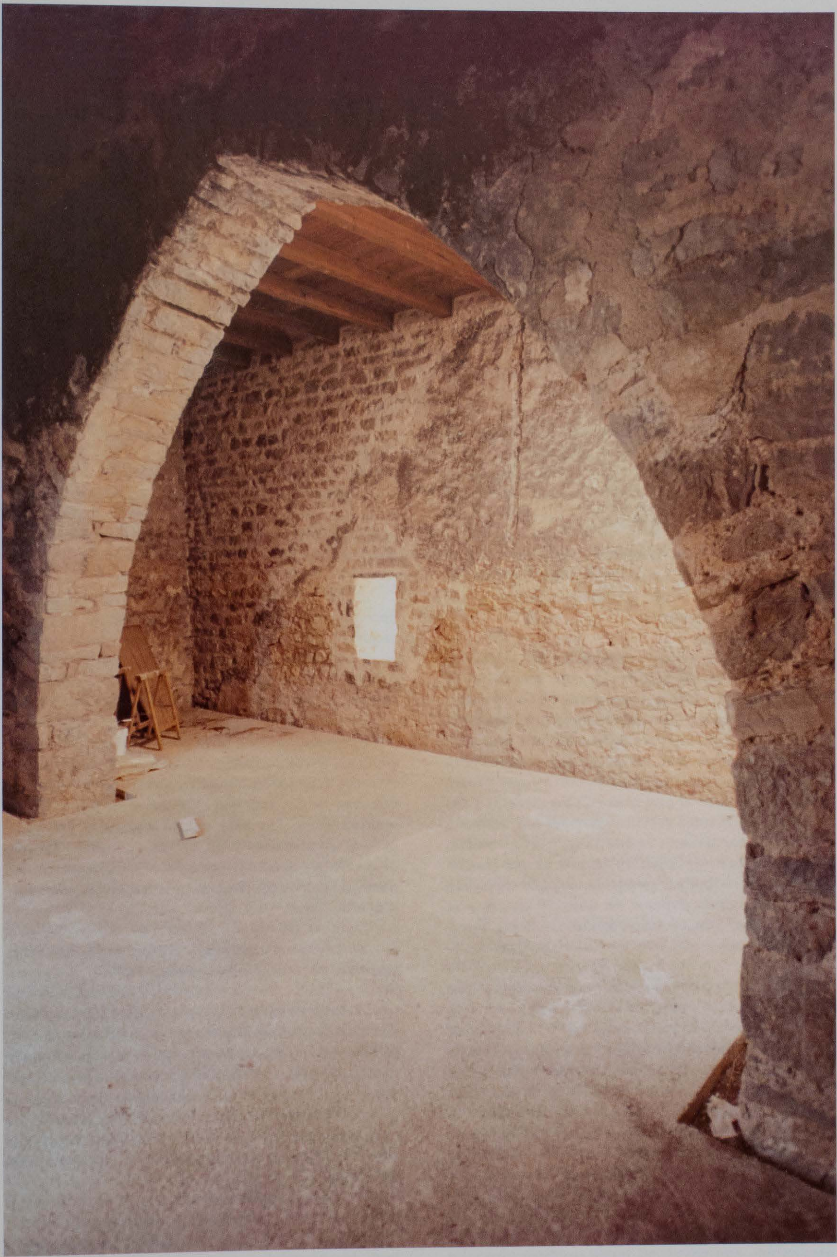
Torre sur. Aspecto del interior, completamente restaurado.
