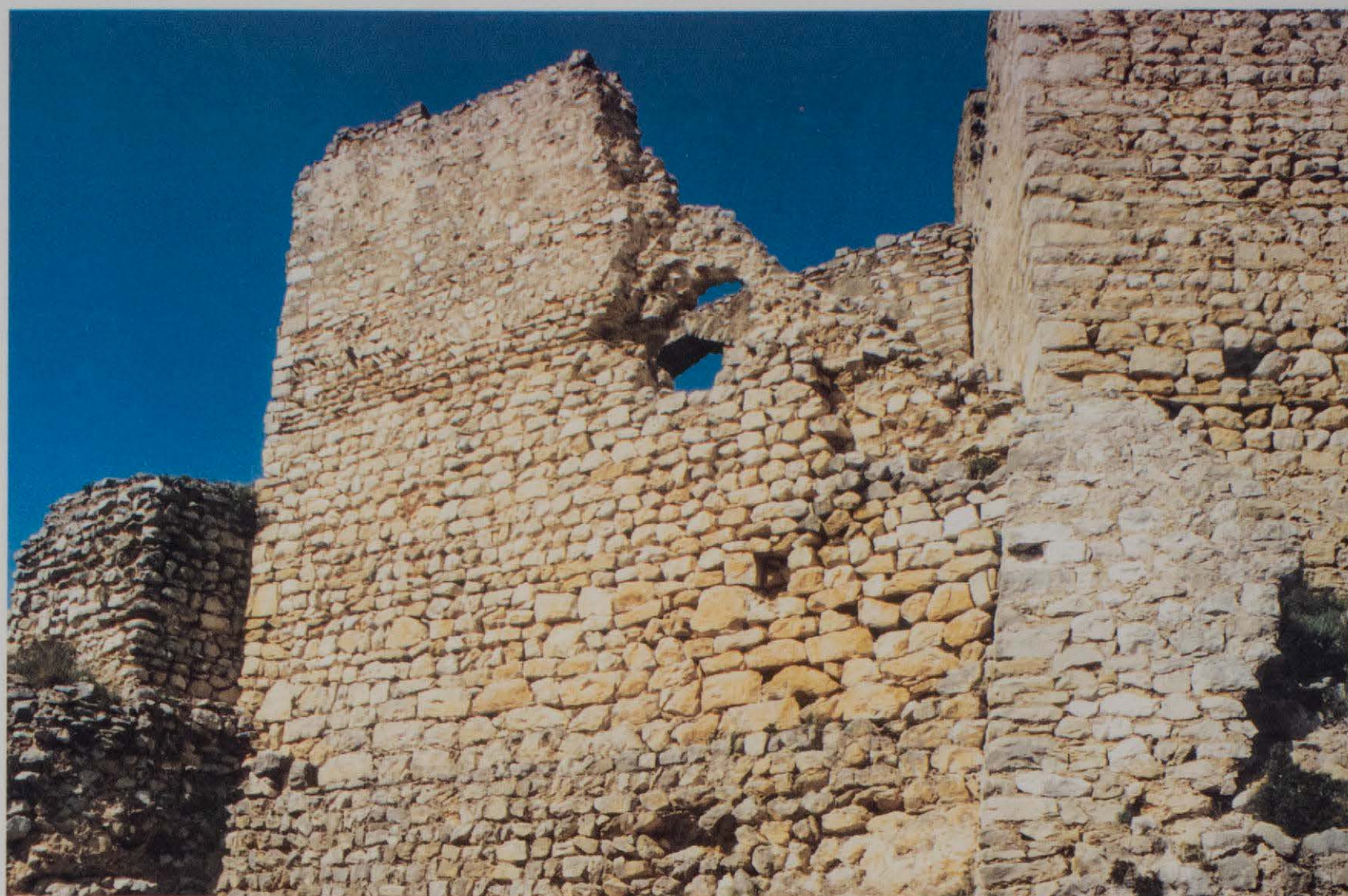
Torre sur. Estado de conservación en el año 1998.
