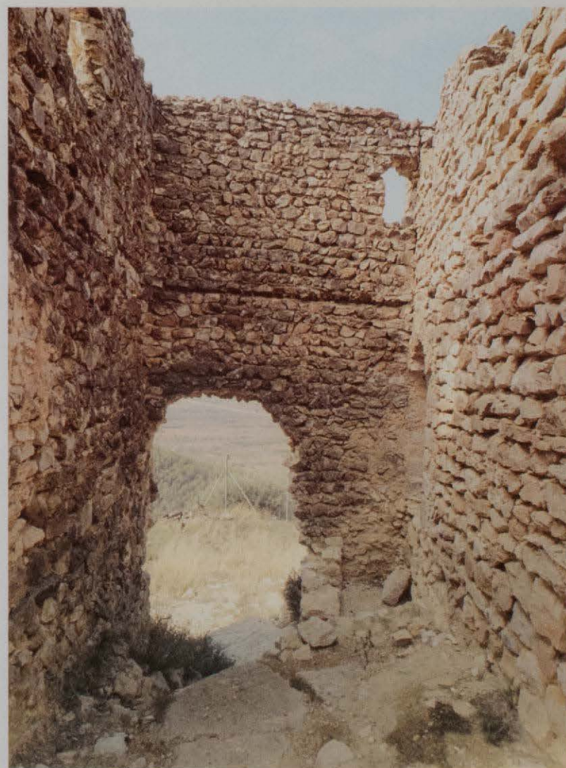
Poblado morisco. Interior de vivienda.
