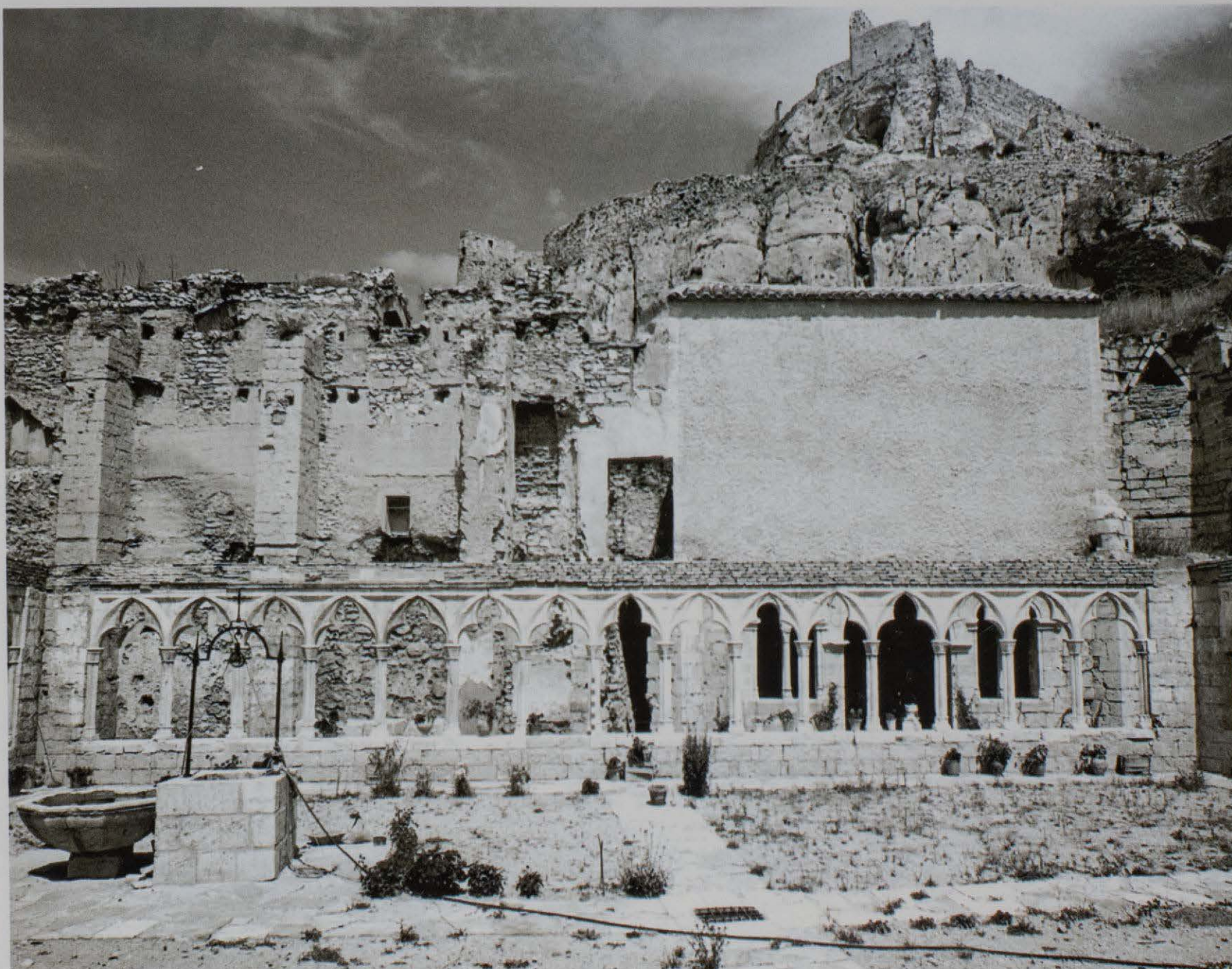
El convento de San Francisco en los años 70, después de la primera intervención arquitectónica de restauración.
