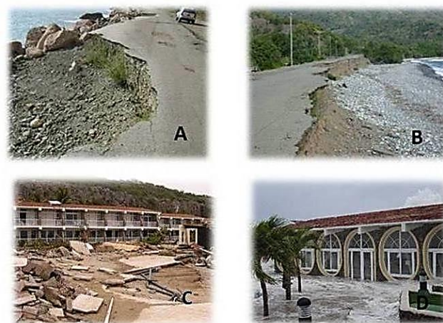
Figura 20. Imágenes de áreas afectadas por efecto de la acción erosiva combinada del viento, el mar y las lluvias en temporada ciclónica: Carretera Granma en el municipio Guamá (A y B); Hotel Bucanero (C y D). Fuente: Fotografías tomadas por los autores.
