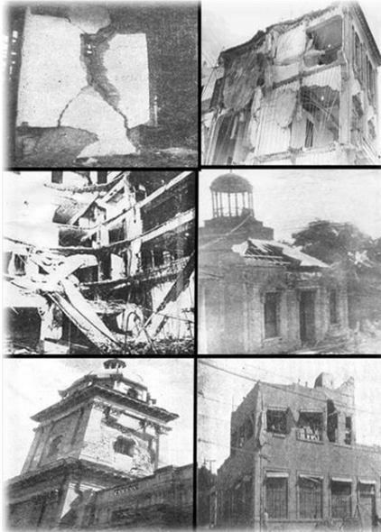
Figura 1. Imágenes de daños ocasionados en la ciudad de Santiago de Cuba por el terremoto de 1932. Fuente: Archivos del Centro Nacional de Investigaciones Sismológicas. Cuba. Cortesía del Centro.
