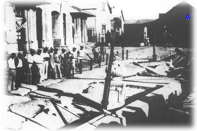
Figura 12. Afectaciones que se produjeron en la zona de la Alameda (Avenida Jesús Menéndez), en la ciudad de Santiago de Cuba durante el terremoto del 3 de febrero de 1932, causadas probablemente por la licuefacción del terreno.
