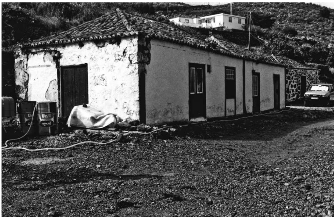
Figura 5. Vivienda abandonada. Villa de Mazo. La Palma. Islas Canarias Fotografía: Víctor Manuel Cabrera García
