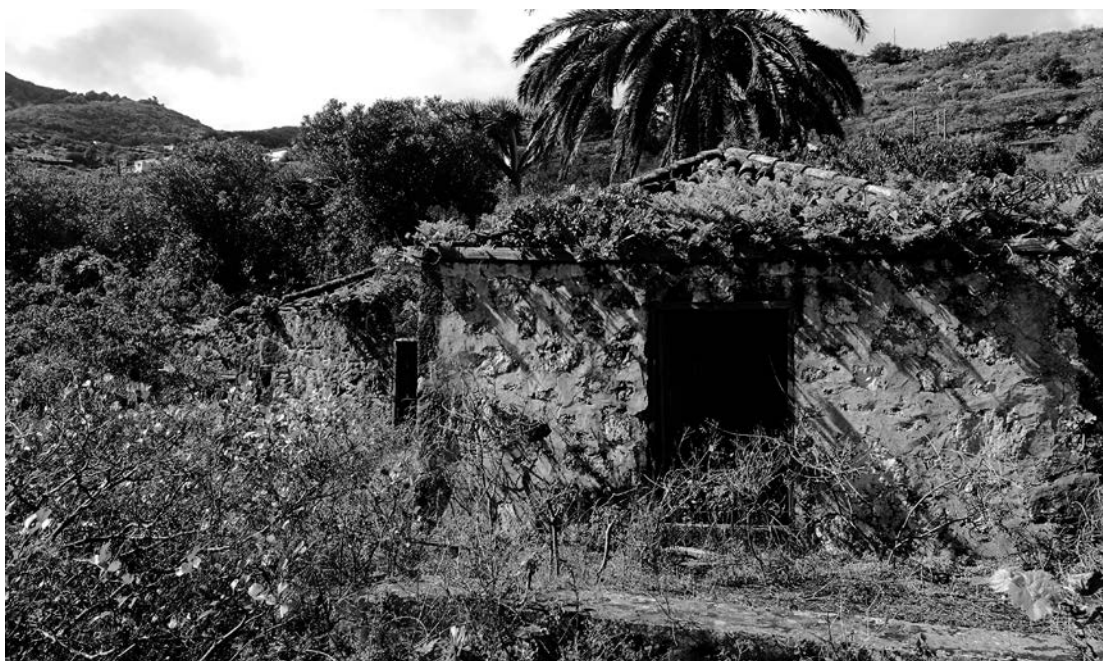
Figura 3. Vivienda unifamiliar abandonada y en ruina. Villa de Mazo. La Palma. Islas Canarias. Fotografía: Víctor Manuel Cabrera García
