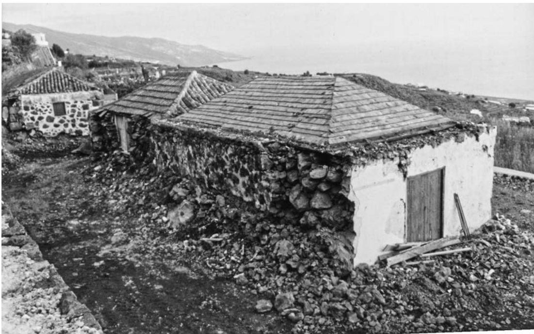
Figura 4. Vivienda abandonada y en ruina. Villa de Mazo. La Palma. Islas Canarias Fotografía: Víctor Manuel Cabrera García
