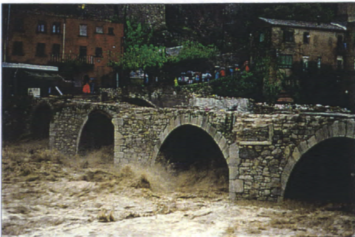
Fotografies 1 i 2. El pont de Cal Cisquet a la Riba, després de la riuada de Sant Lluç (1930) (Foto de J.Lladó, Arxiu de la revista El Brugent) i a la tarda del 10 d'Octubre de 1994 (Foto J.Pujadas). Es poden comparar els efectes d'ambdues riuades sobre aquest pont
