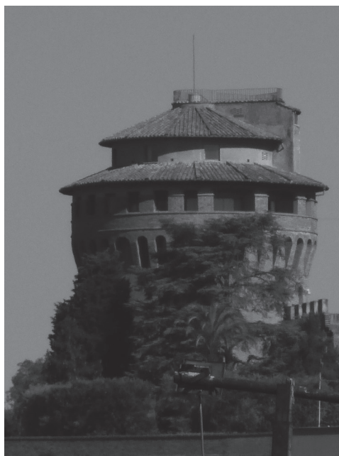
Fig. 4. Torre di San Giovanni.
