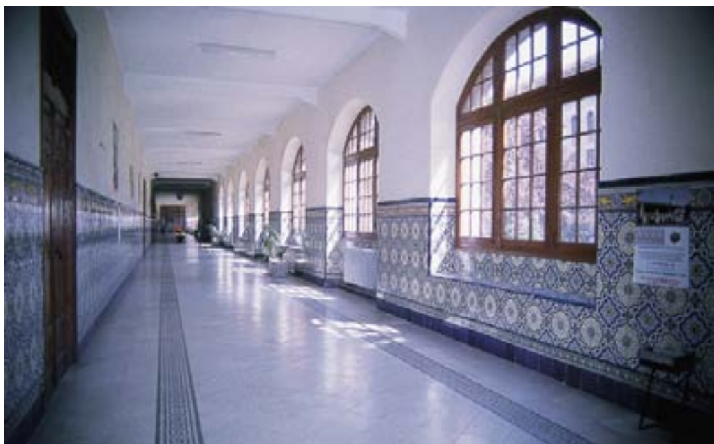
16- Distribuidor del Pabellón de Teólogos donde se percibe la sensación de amplitud y luminosidad que reina en todo el edificio.
