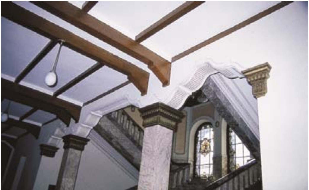
14- Arranque de la escalera imperial con el detalle de columnas capitel – zapata y arcos mixtilíneos.
