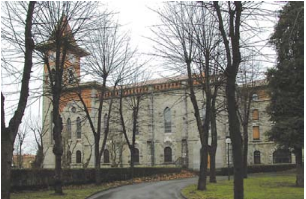
4- Iglesia pública dedicada a N. S. Jesucristo Rey, situada en el lado izquierdo de la fachada principal del Seminario de Vitoria.
