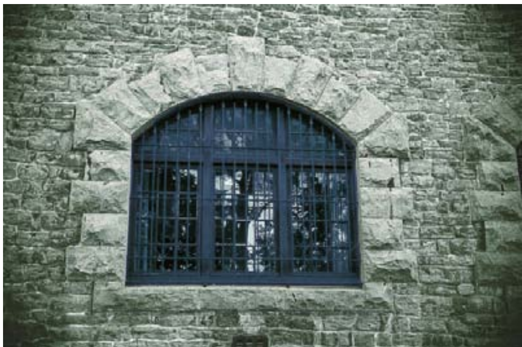
5- Pabellón de Latinos. Detalle de un vano del 1er. Piso.
