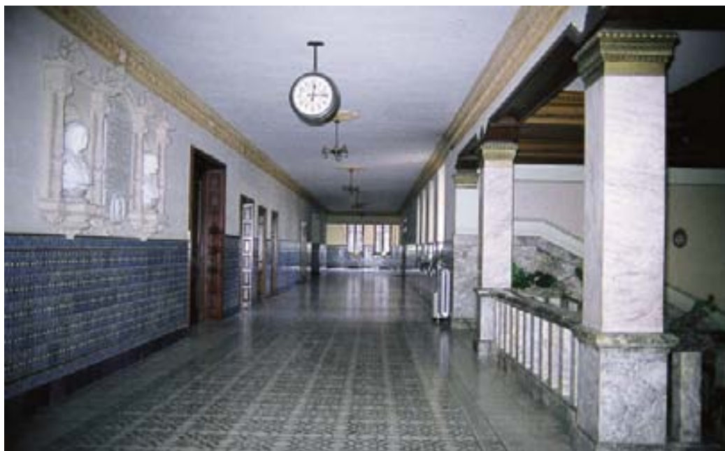
15- Piso principal distribuidor que une los pabellones de Latinos, Filósofos y Teólogos. A la Izquierda se detecta en sendas hornacinas, los bustos de los promotores de la construcción del Seminario Diocesano.
