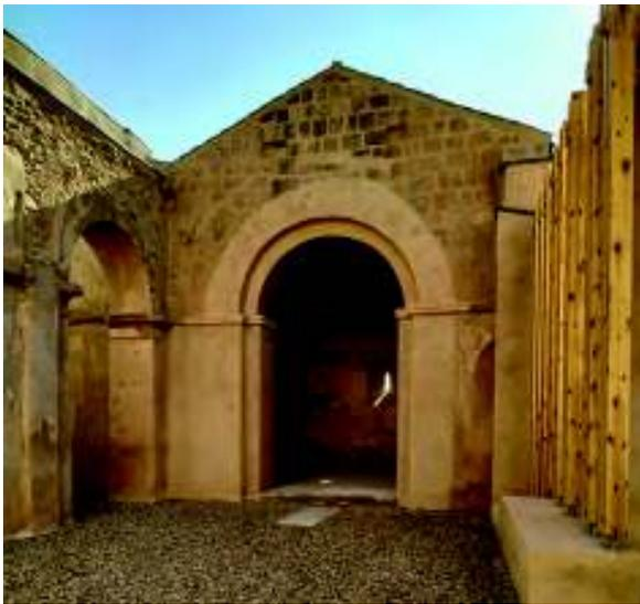
*Fig. 38. Arco de gloria restituído con hormigón ciclópeo de cal a partir de la traza original encontrada mediante cata arqueológica.*
