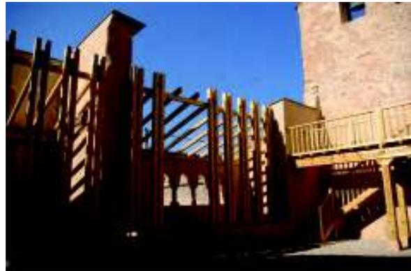
*Fig. 39. Estructura de madera reinterpretando la envolvente de la galería (tanto su cubierta como el muro sur caído), y vista parcial del nuevo coro.*
