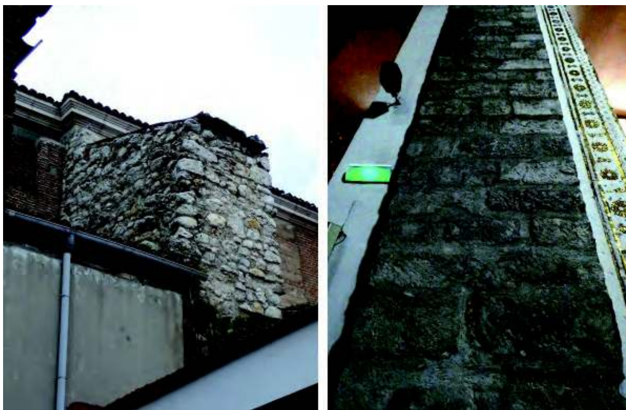
Figura 6. Contrafuerte y detalle de la pilastra entre los tramos primero y segundo, lado del Evangelio, de la iglesia de San Andrés. Probablemente se trata de los pilares cuya construcción se llevó en 1605 Cristóbal Velázquez. Puede apreciarse la variedad de tallas de mampuestos y sillares, con sus distintas labras, seguramente por haberse realizado con materiales procedentes de construcciones desmontadas, como la puerta de San Esteban de la segunda cerca vallisoletana.
