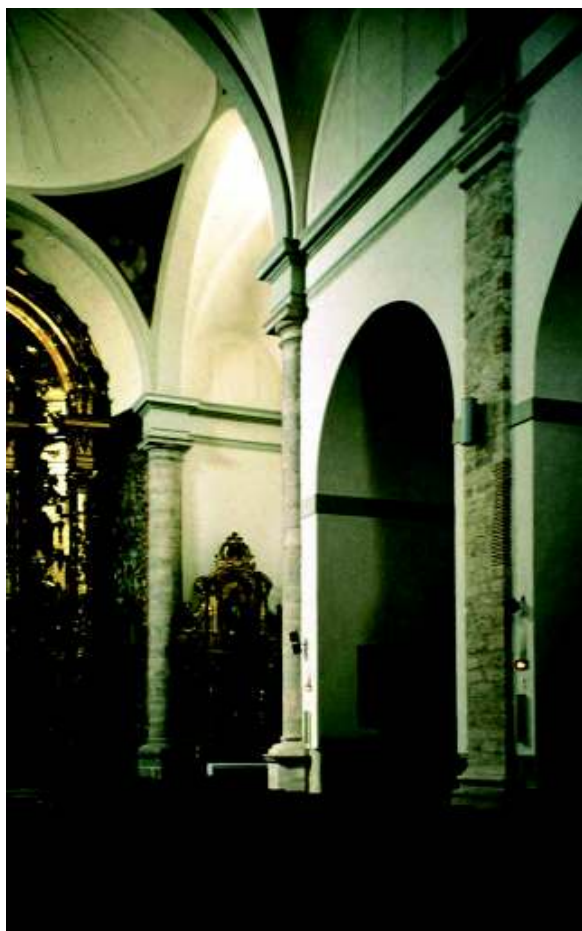
Figura 5. Iglesia de San Andrés de Valladolid: lado de la Epístola de la nave hacia la cabecera, mostrando los pilares columnados del crucero y las pilastras entre el primero y segundo tramo de la nave, con sus capillas laterales.
