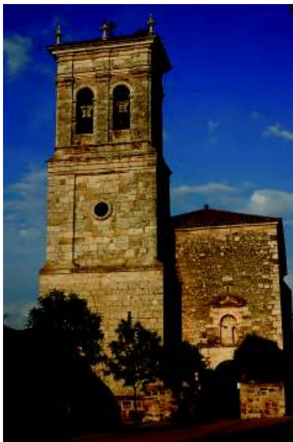
Figura 2. Torre y nave de la iglesia de la Asunción de N a S a en Quintanilla de Arriba.
