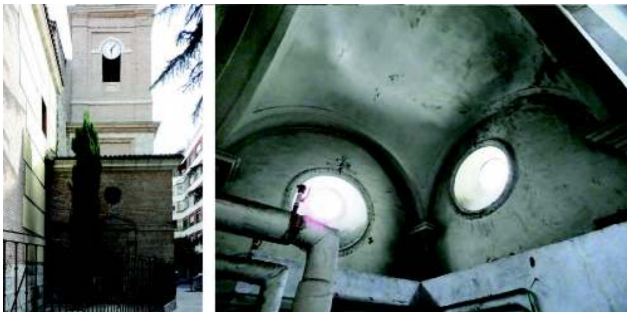
Figura 20. Capilla adosada a la torre de San Andrés, tanto exterior como interiormente, mostrando sus óculos y su bóveda baída.
