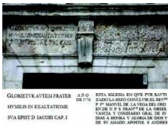
Figura 18. Inscripciones sobre el dintel de la puerta principal de la iglesia, haciendo referencia al P. Vega. Inicialmente (según Floranes, 1782, 151), las letras fueron doradas, pero solo se conservan sus huellas, aunque pueden reconstruirse gracias a que lo recogió este erudito. La parte de la izquierda es una cita del versículo 6 del capítulo I de la Epístola de Santiago que podría traducirse como “gloríese el hermano pobre en su exaltación”, seguramente haciendo referencia a los orígenes humildes del P. Vega.
