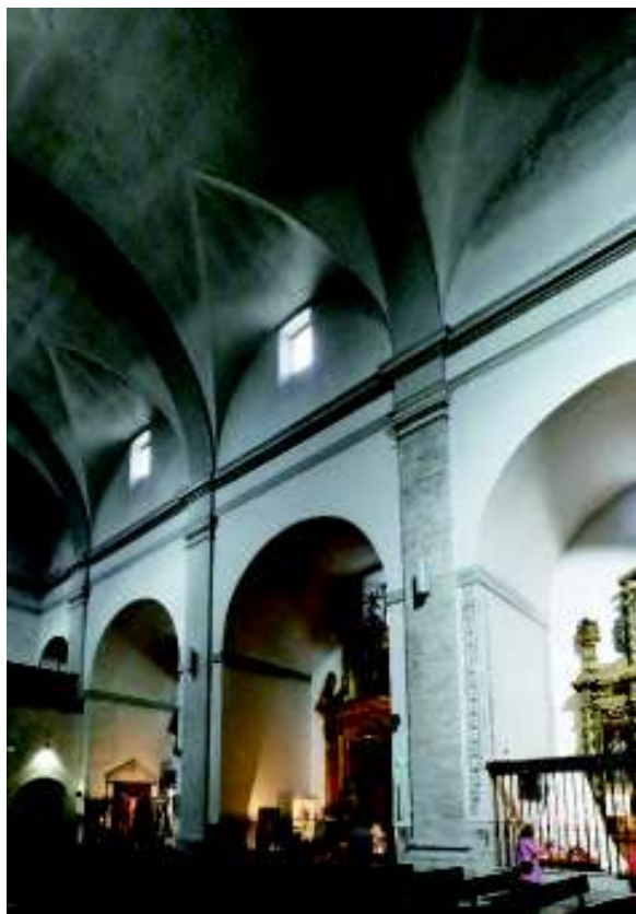
Figura 11. Lado del Evangelio de la nave de San Andrés de Valladolid, hacia los pies. Los tres últimos tramos –contando también el del coro– fueron los construidos por Pedro González Ortiz entre 1772 y 1776 en correspondencia de lo ya ejecutado.
