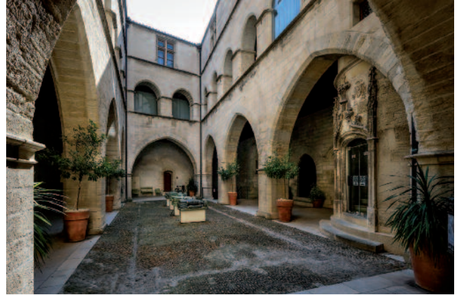
Fig. 3. Avignone. Petit Palais, corte interna con gli interventi di Alain de Coëtivy sul primitivo impianto trecentesco.
