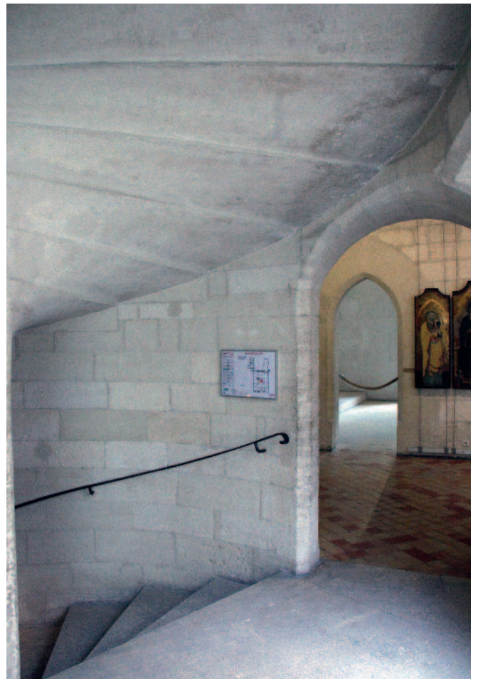
Fig. 5. Avignone. Petit Palais, interno della torre scala.
