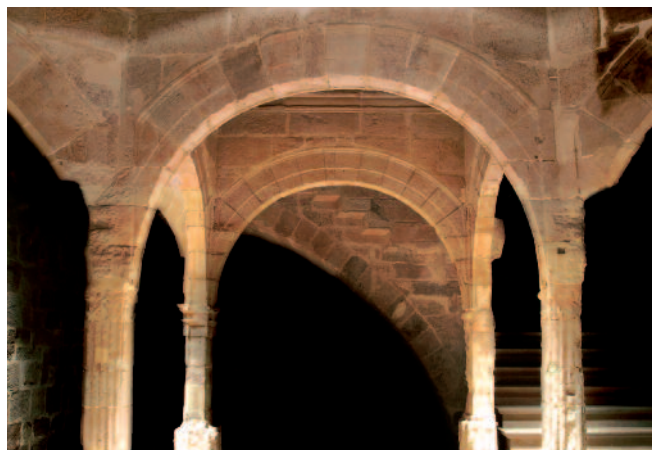
Fig. 6. Cardona. Casa Rovira, estructura del claustro en planta baja una vez restaurado.
