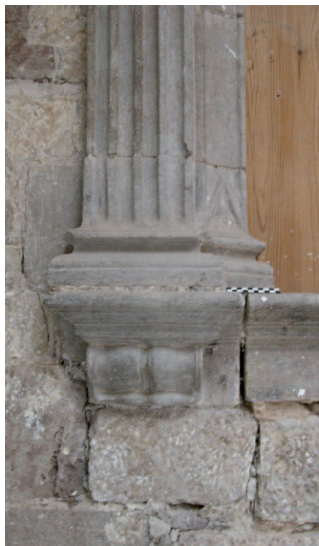
Fig. 12. Cardona. Casa Rovira, detalle de los basamentos y pilastras laterales de las ventanas del corredor del claustro (foto de A. Pancorbo, 2005).
