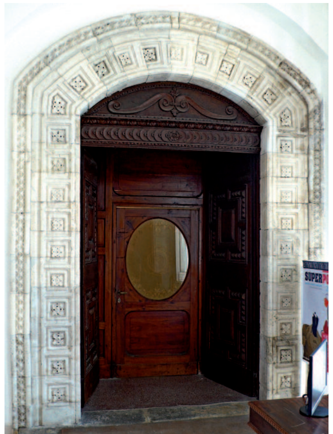
Fig. 9. Vasto. Palazzo Caldora, poi d'Avalos, porta degli appartamenti al piano nobile.
