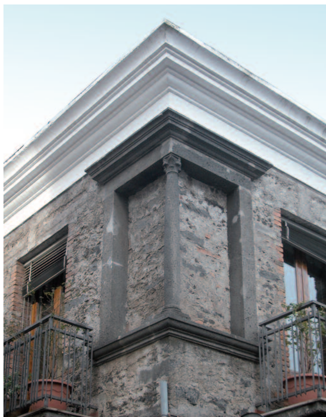
Fig. 12. Randazzo (Ct), palazzetto, finestra angolare (foto M.R. Nobile).
