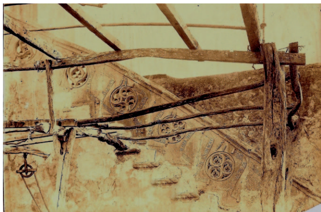
Fig. 10. Palma. Escalera de la calle del Agua remontada en Son Hugo (?) (cortesía de M. Quiroga).
