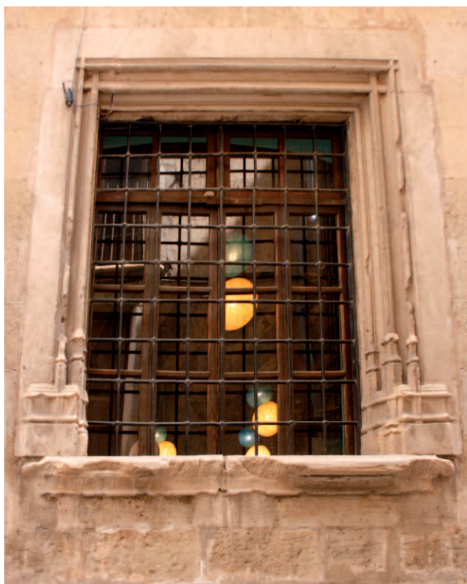
Fig. 13. Palma de Mallorca. Ventana rectangular con baquetones de Can Burgues (foto de HAR2016-77032-P, MINECO/AEI/FEDER, UE).
