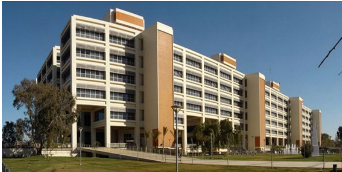
Figura 7. Fachada este Edificio Centro Cívico. Fuente: Elaboración de las autoras.
